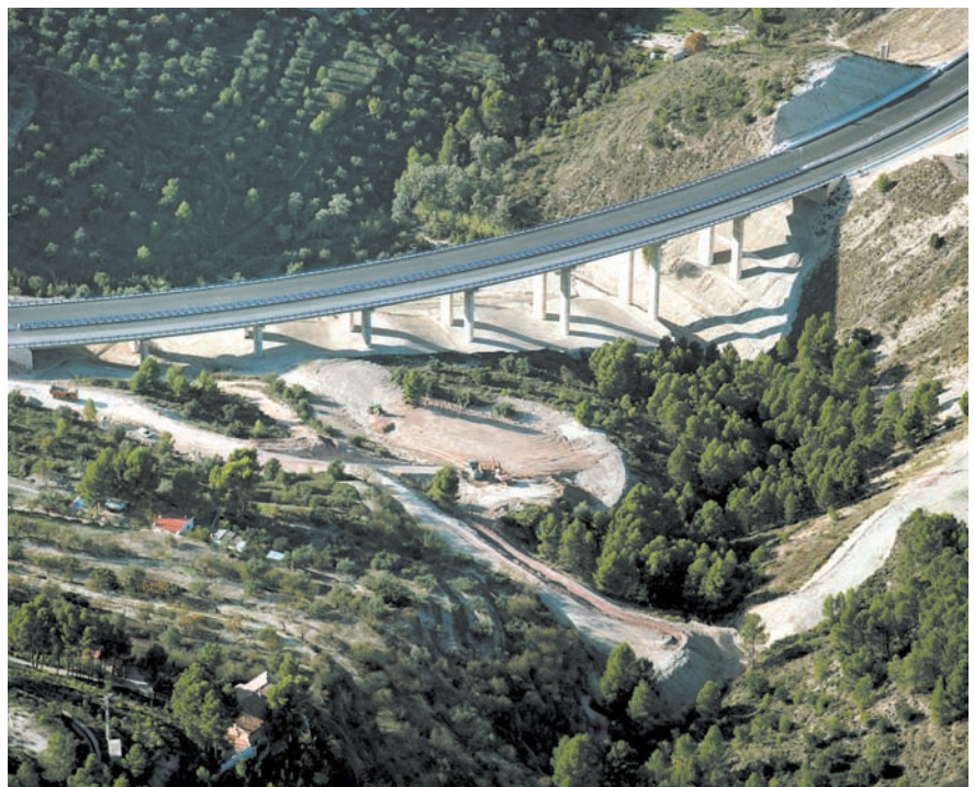
Viaducto sobre el Barranco de la Caña, de 280 m de longitud, con altura máxima de pila de 34 m.
