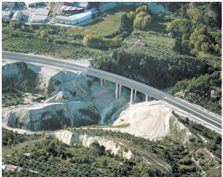
Viaducto sobre el Barranco del Cuquet, de 160 m de longitud y altura máxima de pilas de 40 m.
