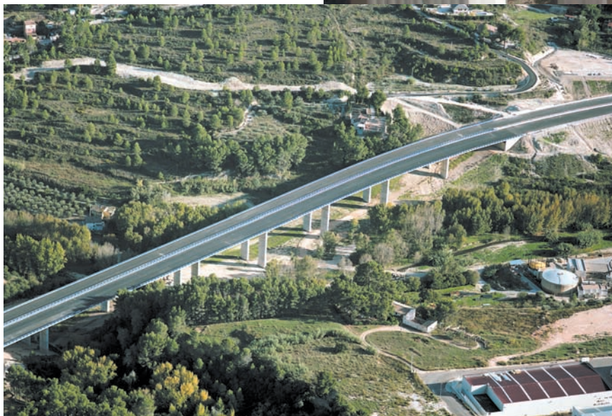
Viaducto sobre el río Serpis, de 462 m de longitud.
