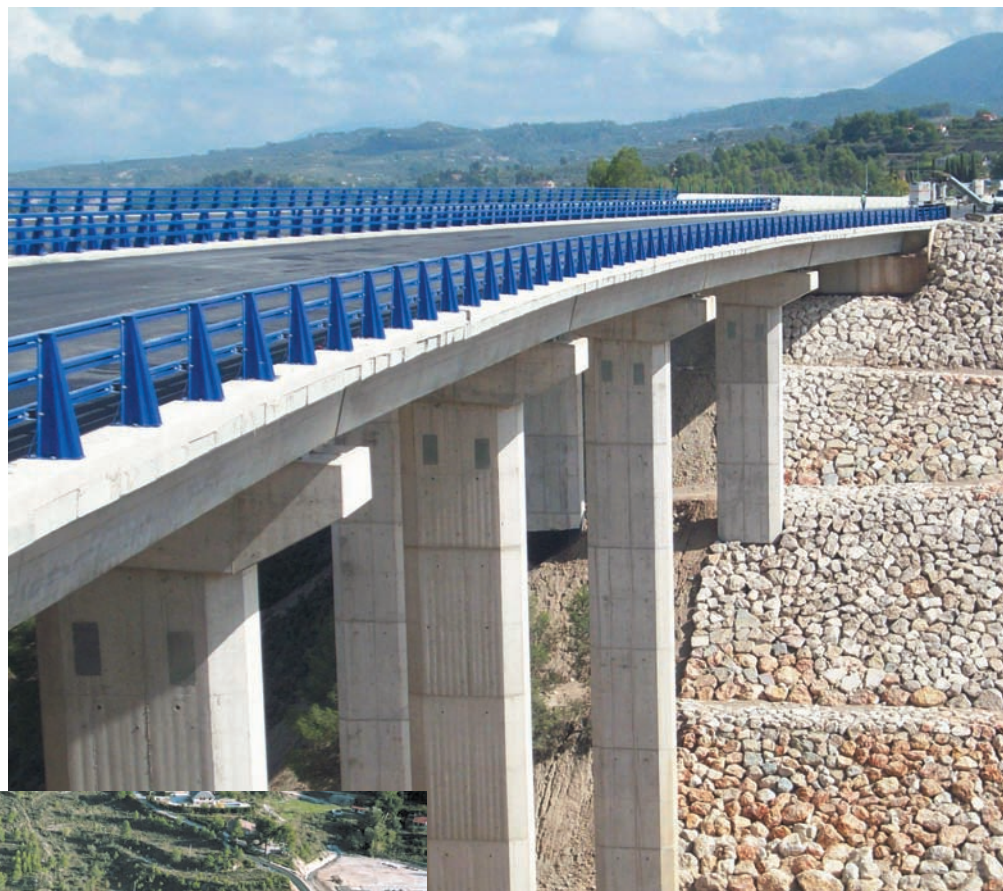
Viaducto sobre el Barranco del Cuquet. Protección de cimentaciones en ladera.
