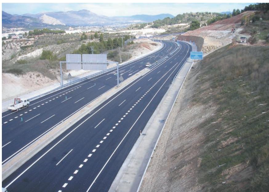
Tramo de la variante coincidente con el p.k. 50,4 de la A-7. A la derecha puede verse uno de los muros de sostenimiento de escollera y la protección de taludes.
