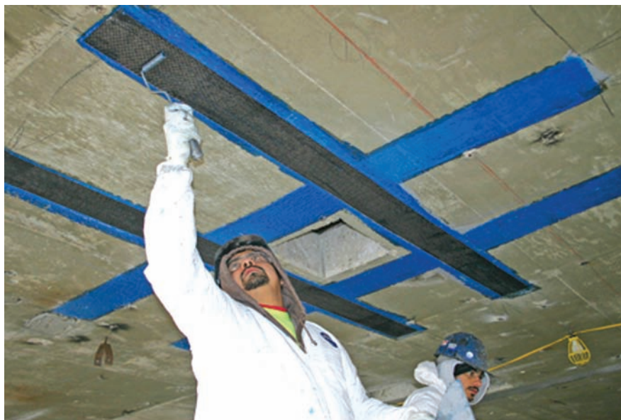
Figura 8. Refuerzo con laminados.
