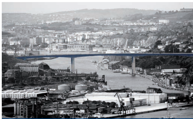
Figura 13. Puente de Rontegui.
