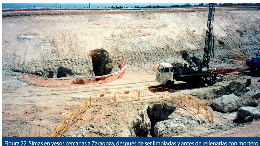
Figura 22. Simas en yesos cercanas a Zaragoza, después de ser limpiadas y antes de rellenarlas con mortero.
