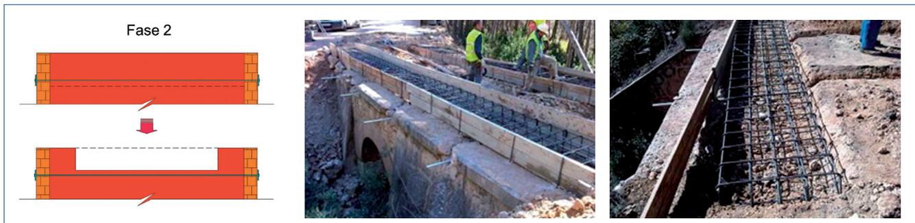
Figura 11. Actuación en Fase 2 de barras transversales de atado y excavación para vigas de apoyo.
