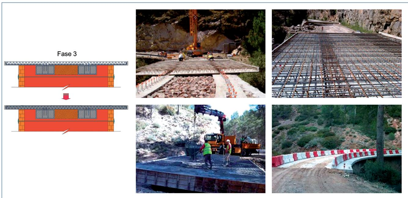
Figura 12. Actuación en Fase 3, hormigonado de vigas de apoyo, disposición de prelasas y acabado de la losa.
