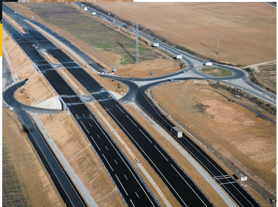
Vistas parciales del tramo finalizado, de 4200 m de longitud, y diseñado para una velocidad de 120 km/h.
