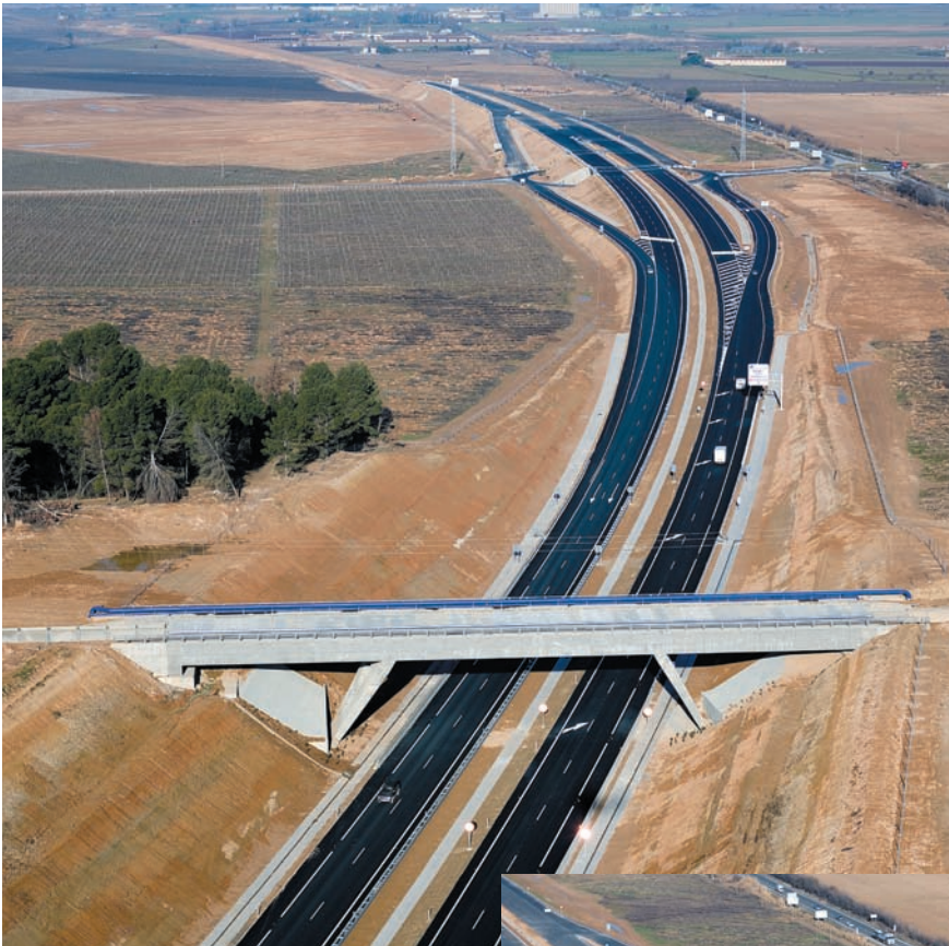
Vistas parciales del tramo finalizado, de 4200 m de longitud, y diseñado para una velocidad de 120 km/h.
