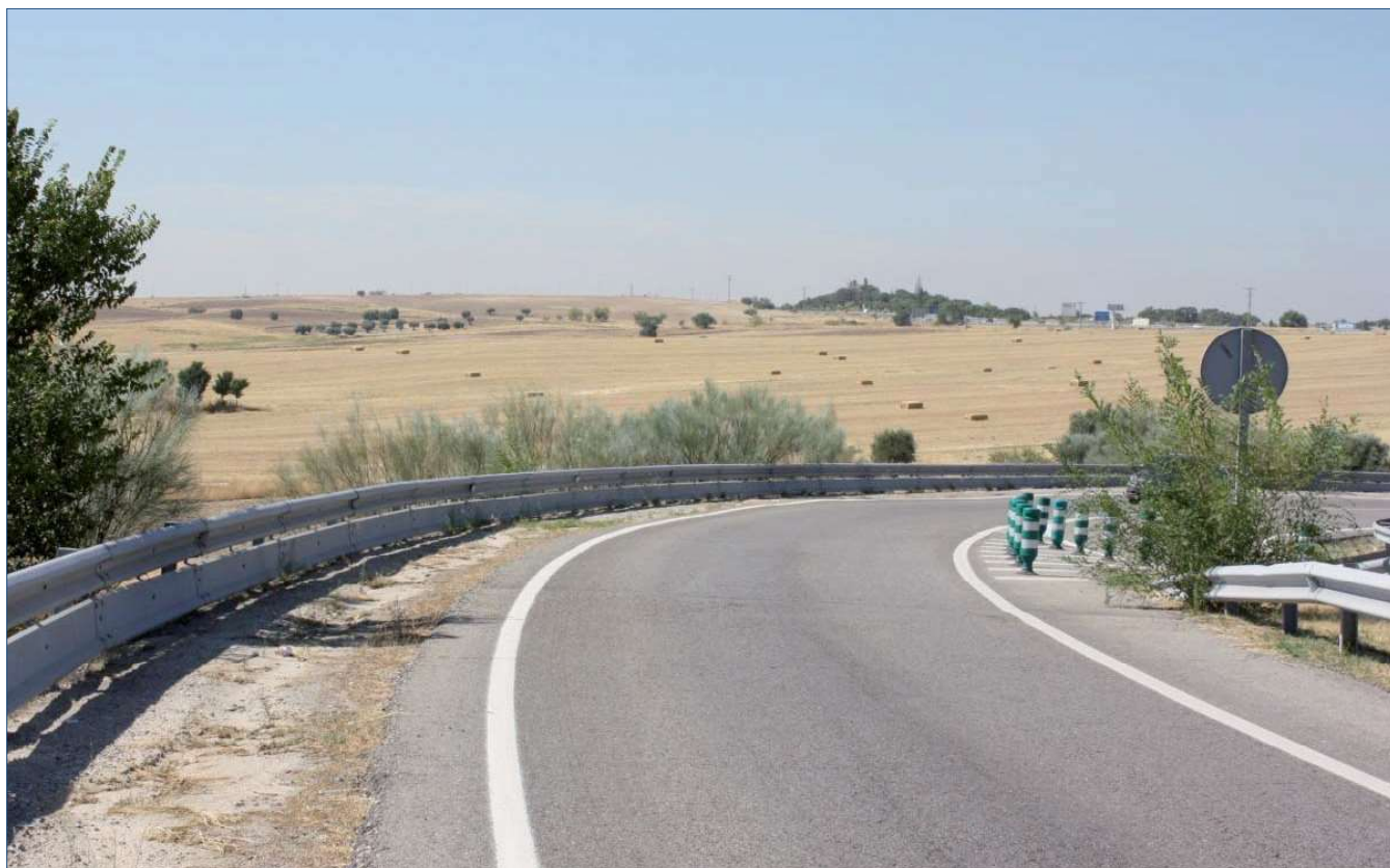
Figura 7. Barrera de seguridad con dispositivos de protección de motoristas
