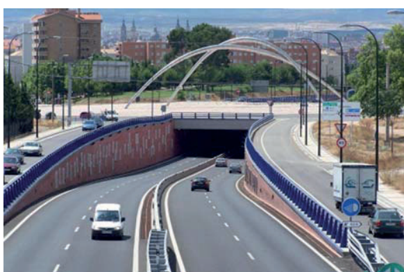
Túnel glorieta de la MAZ (ZARAGOZA)
