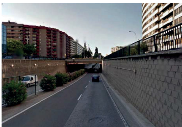
Túnel Avenida Cesáreo Alierta (ZARAGOZA)
