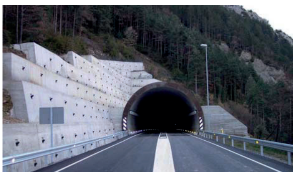
Túnel de Campo (HUESCA)
