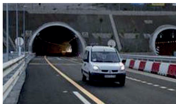
Túnel de Cantalobos (MÁLAGA)
