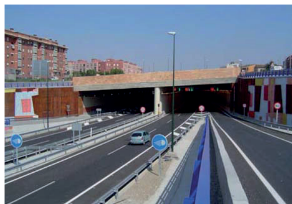
Túnel Ronda Este (Santa Isabel, ZARAGOZA)
