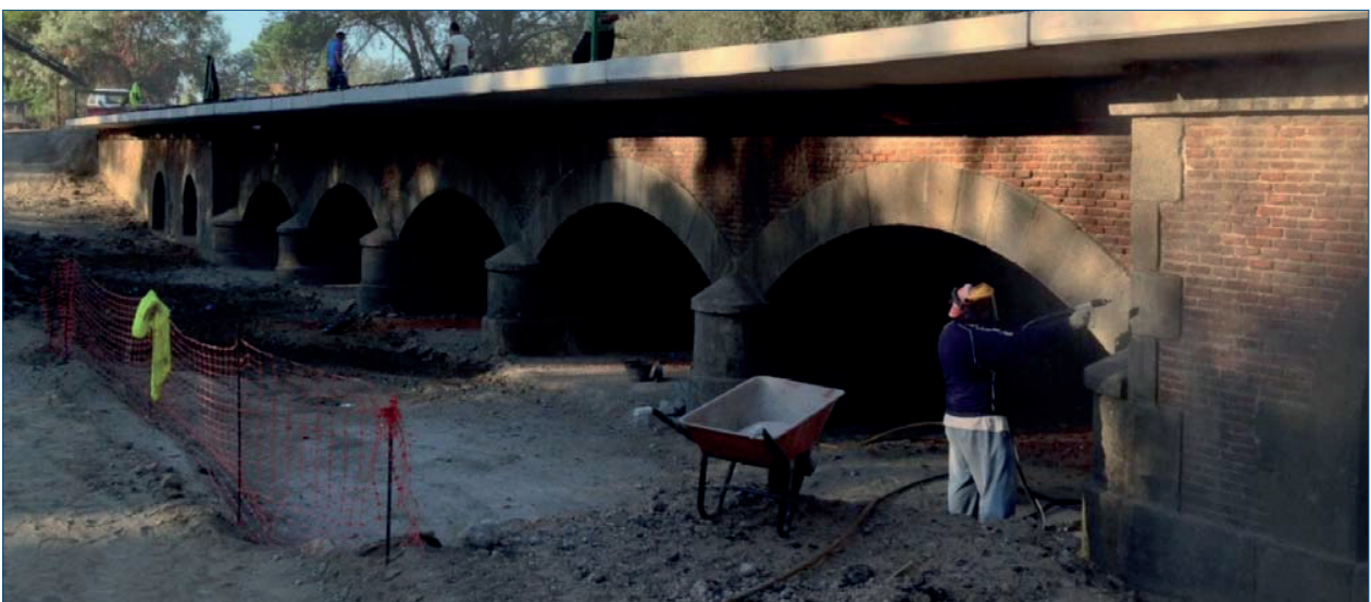
Limpieza con chorro de arena
