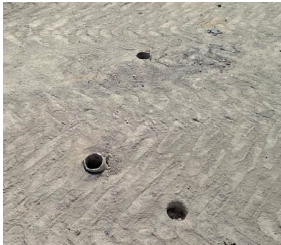
Detalle micropilotes en estribos
