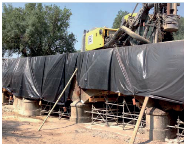
Protección de la estructura con plásticos
