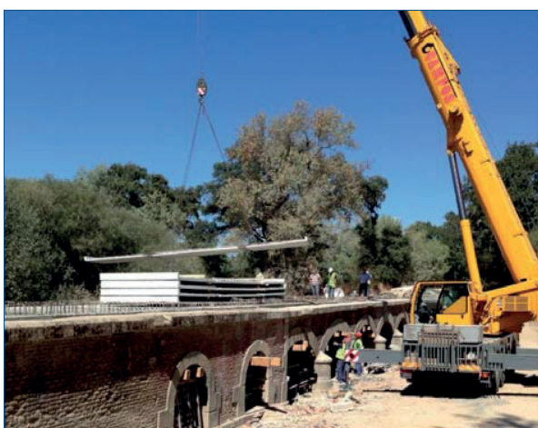
Colocación de prelomas
