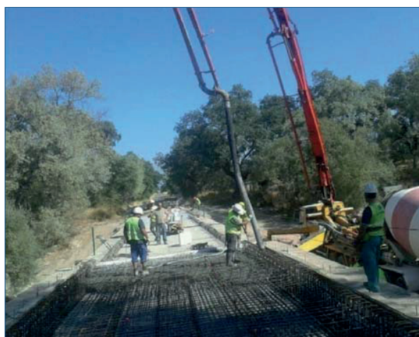
Hormigonado de estribo
