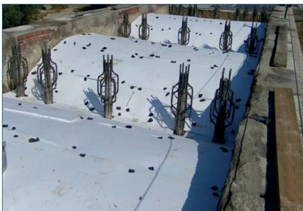
Colocación porexpan en arcos
