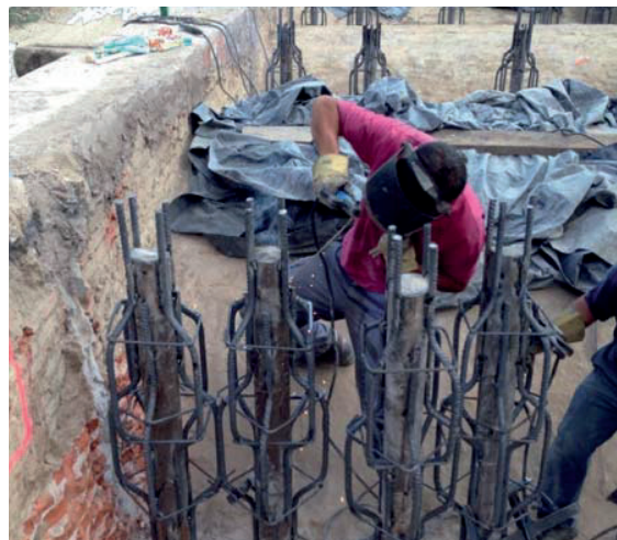
Colocación anclajes en cabeza de micropilotes
