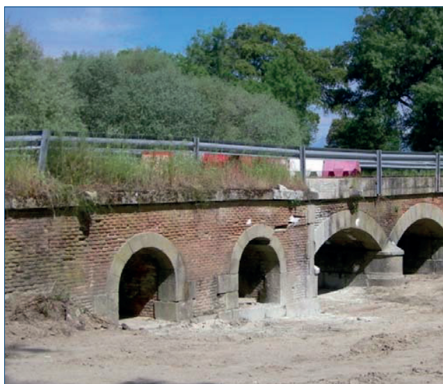
Vista inicial de la estructura aguas arriba
