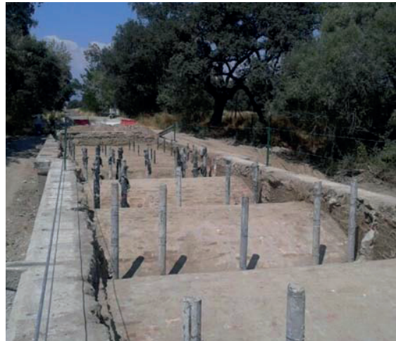
Vaciado timpanos de arcos
