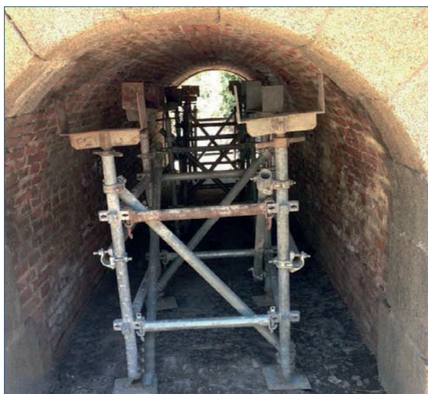
Cimbrado arcos laterales
