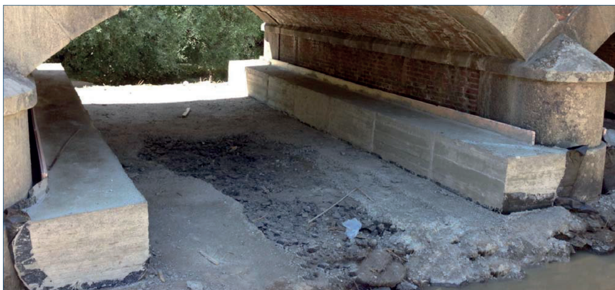
Detalle zapata de apoyo cimbra porticada
