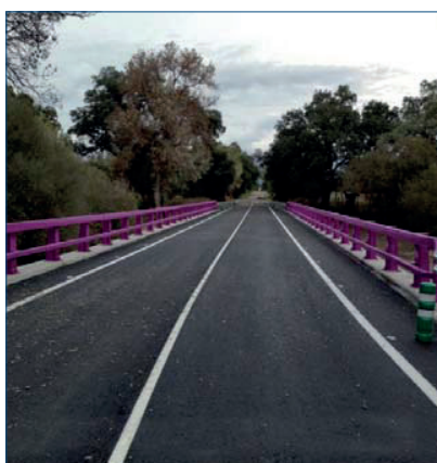
Extendido de aglomerado asfáltico
