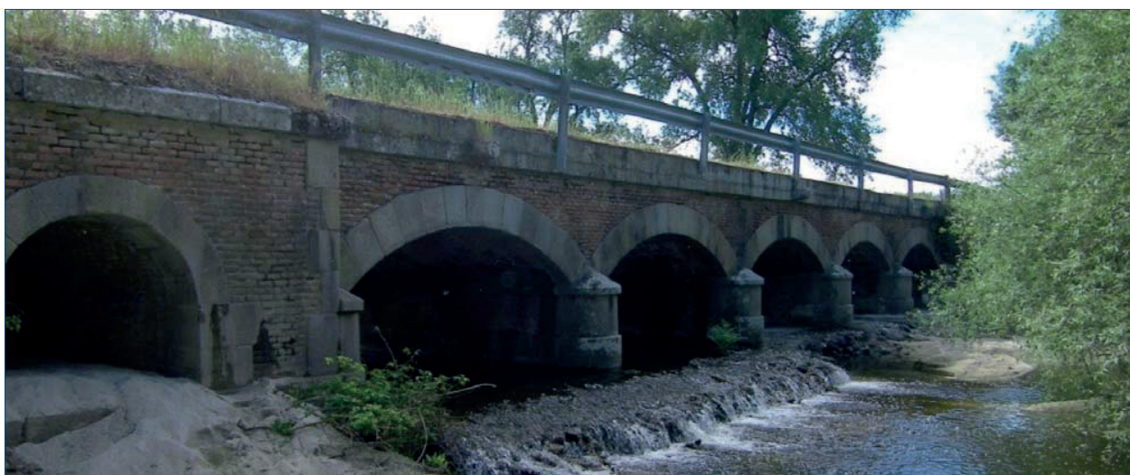
Vista inicial de la estructura aguas abajo
