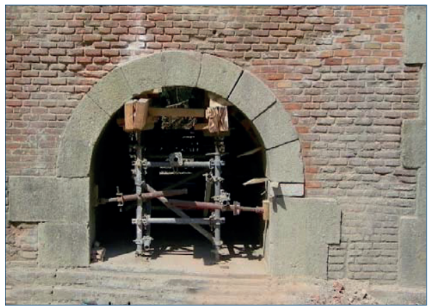
Arreglo del arco colapsado
