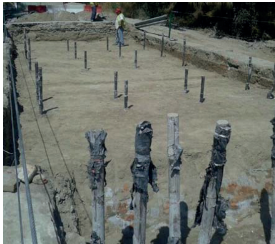
Vaciado timpanos de estribos
