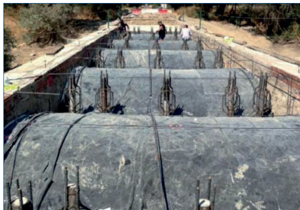
Colocación lámina de plástico
