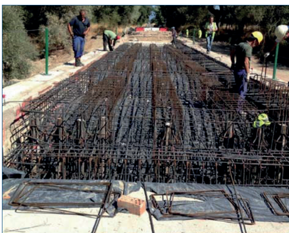
Colocación de armadura en vano central
