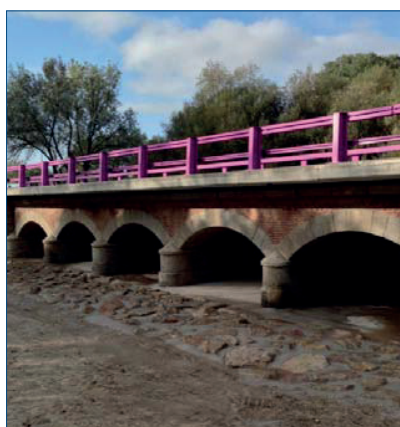
Escollera rejuntada con hormigón
