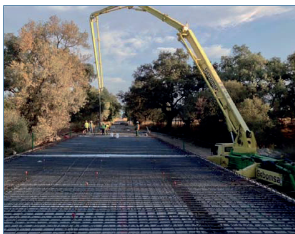
Armado y hormigonado de losas de compresión
