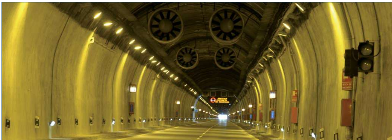
Figura 7. Túnel de Guadarrama
