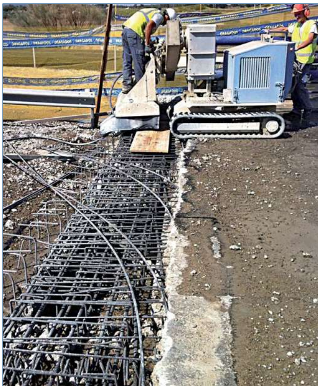
Figura 4. Preparación de una junta para su reparación
