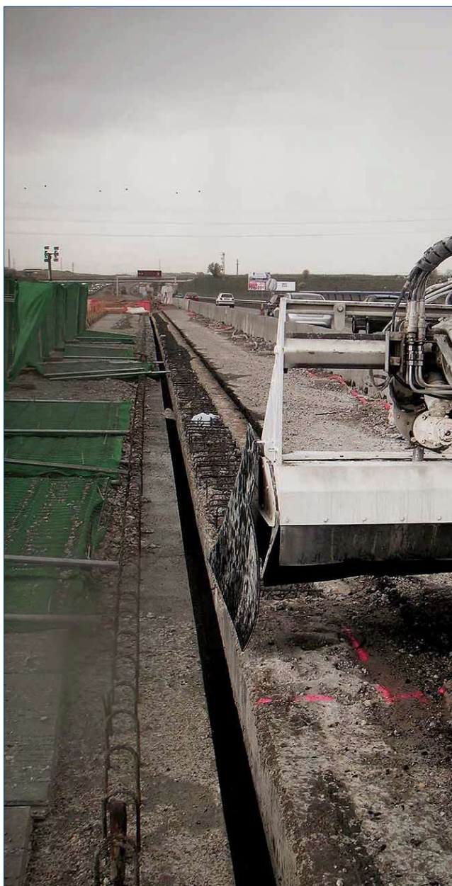
Figura 9. Equipo trabajando en una estructura en servicio
