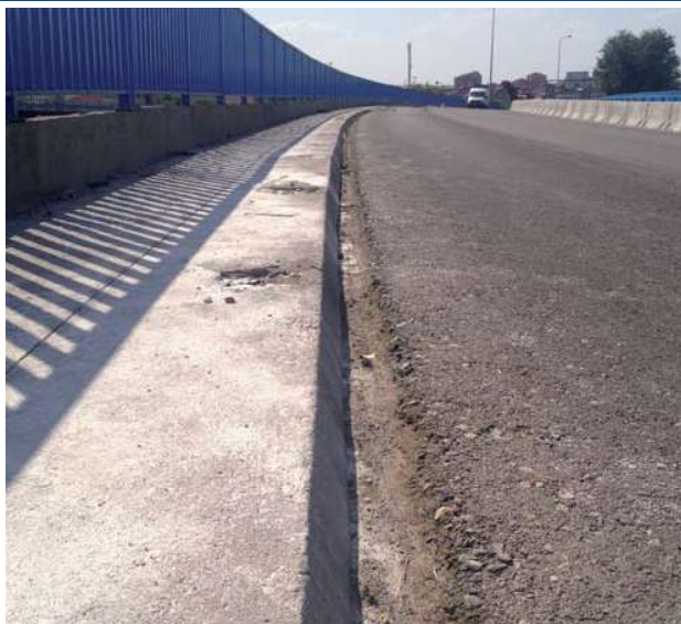
Estado inicial de la estructura
