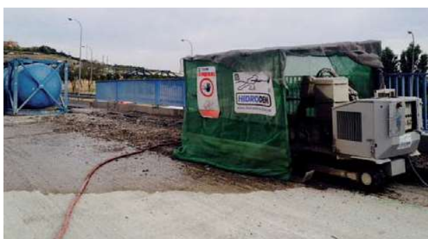
Hidrodemolición del borde del tablero
