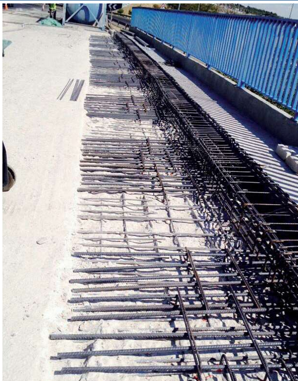
Detalle del nuevo zuncho instalado
