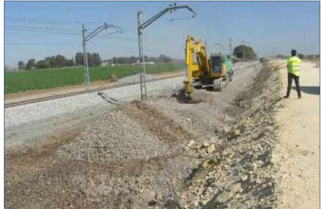
Figura 15. Retirada del balasto de la vía antigua
