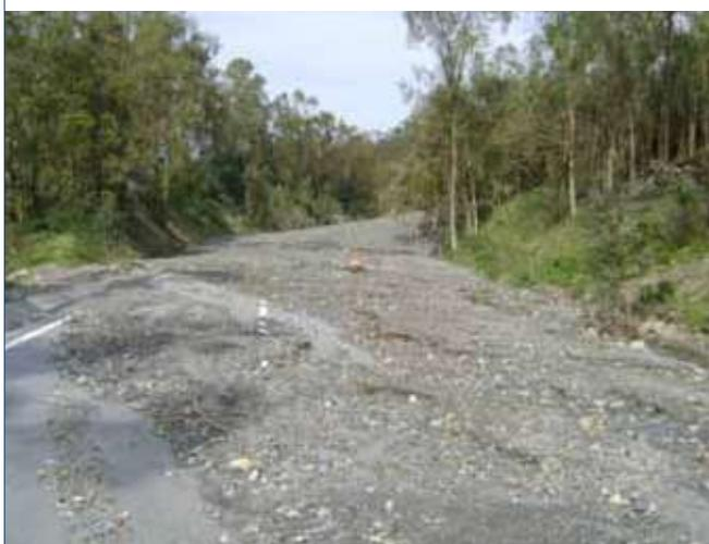
Figura 20. Detalle de la erosión hídrica sobre el talud de desmorte y arrastre de materiales sobre la carretera
