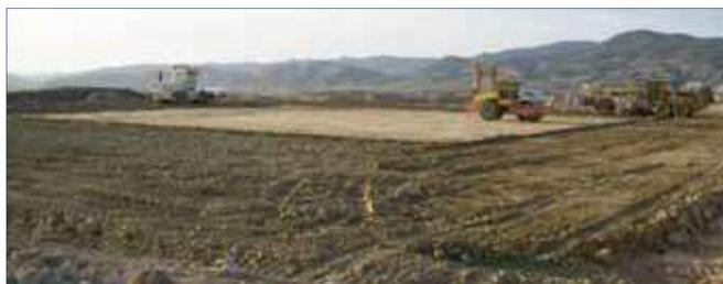
Figura 4. Fase inicial de construcción del terraplén experimental
