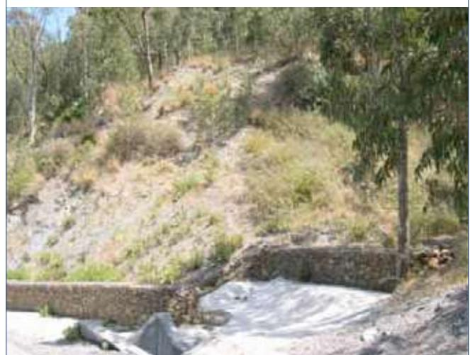
Figura 21. Medidas para reducir la velocidad del agua en cunetas y tratamiento aguas arriba de ODT
