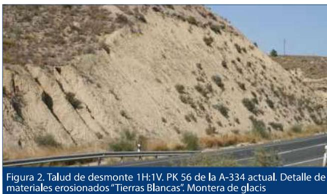
Figura 2. Talud de desmonte 1H:1V. PK 56 de la A-334 actual. Detalle de materiales erosionados "Tierras Blancas". Montera de glaciis
