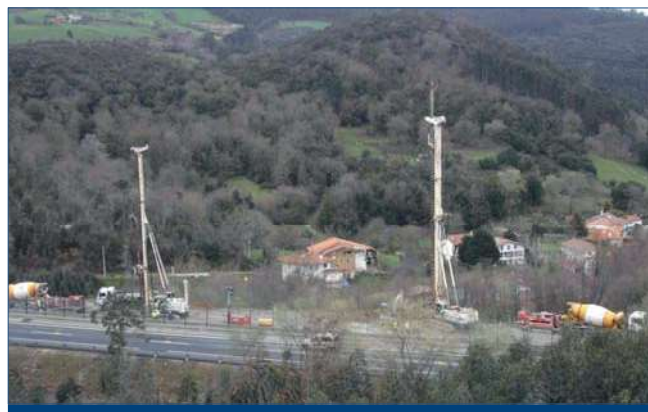
Figura 8. Vista general del tratamiento mediante pilotes de mortero
