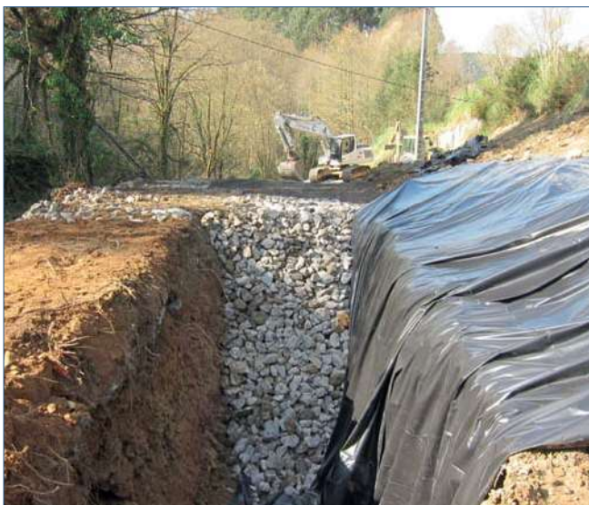
Figura 12. Vista de la zanja drenante de dimensiones de 4,00 x 2,50 m situada al pie del terraplén lado montaña
