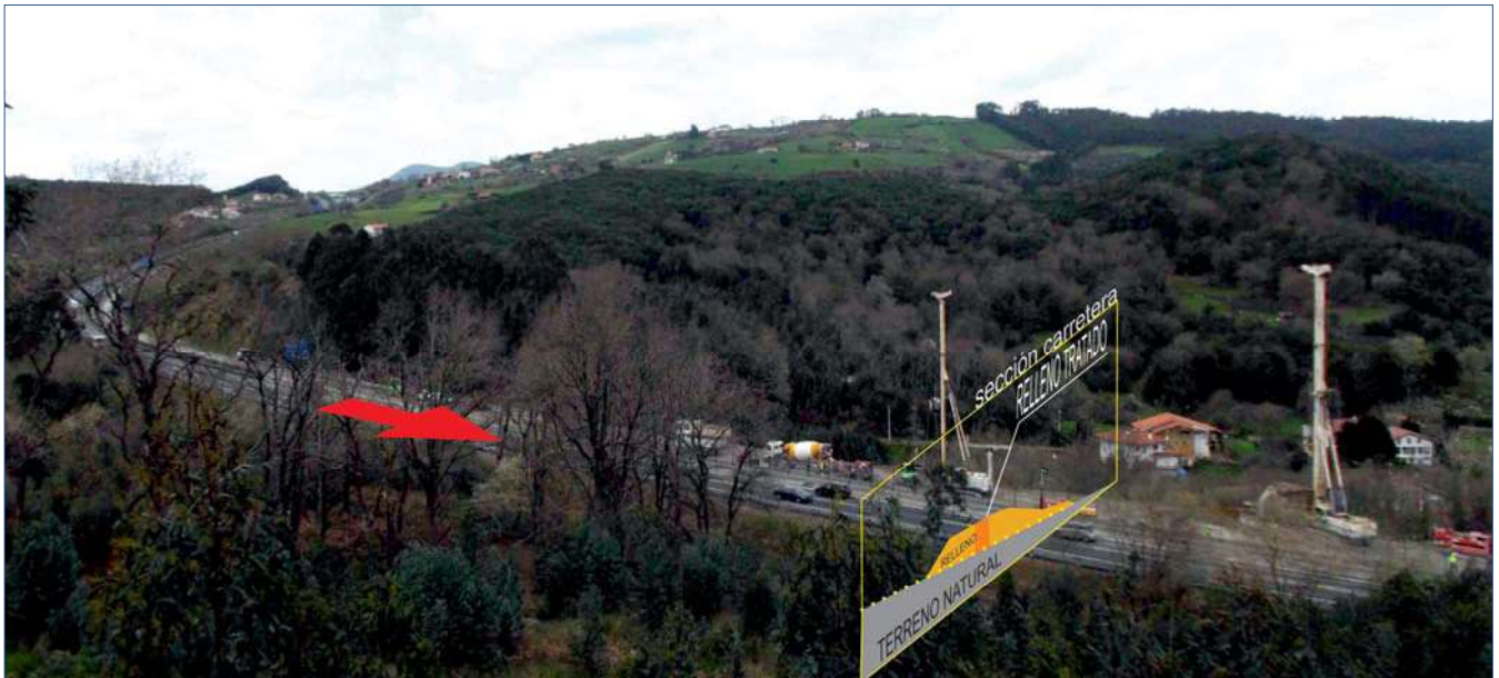
Figura 11. Vista panorámica de la zona a estabilizar
