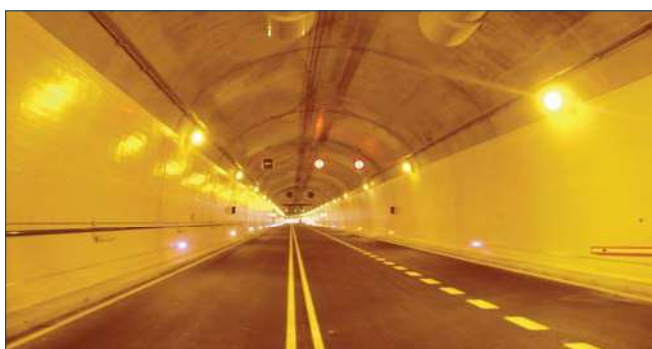
Túnel de Petralba. N-260. Huesca
