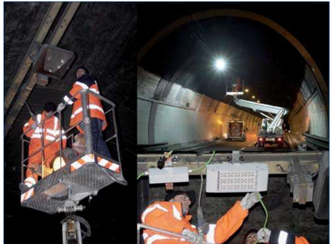
Operarios reemplazando una luminaria
