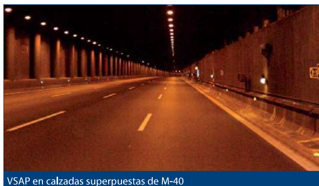
VSAP en calzadas superpuestas de M-40
