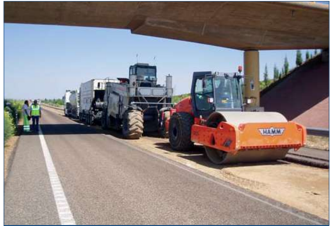
Figura 1. Equipos reciclando con cemento un carril de vehículos pesados de una autovía
