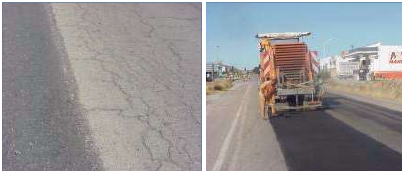
Figura 8. Pavimento antes y después de reciclar con emulsión
