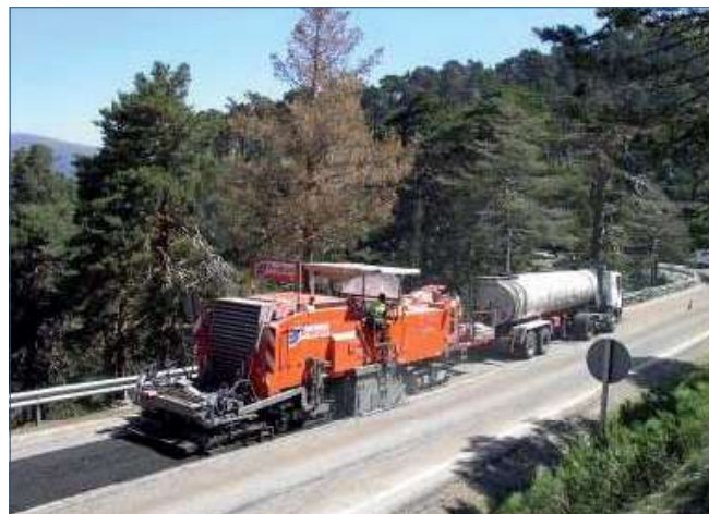
Figura 12. Recicladora con regla de compactación
