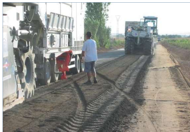
Figura 3. Reciclado in situ con cemento con dos equipos trabajando en paralelo
