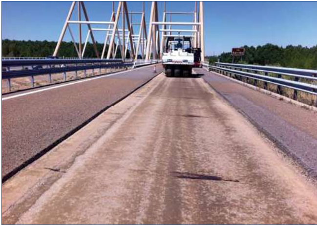
Figura 6. Rodillo compactando el carril reciclado de vehículos pesados de una autovía
