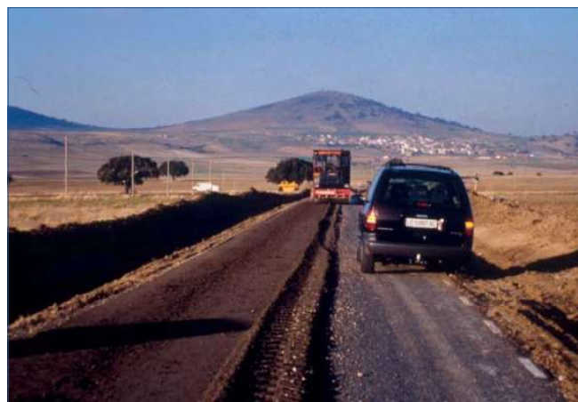
Figura 9. Reciclado in situ con cemento manteniendo el paso del tráfico
