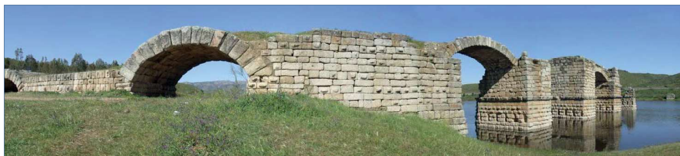
Figura 1. El Puente romano de Alconétar o Mantible en su situación actual
