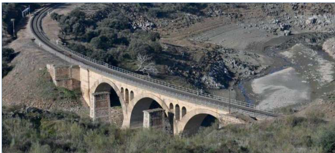
Figura 4. Puente del ferrocarril sobre el arroyo Villoluengo
