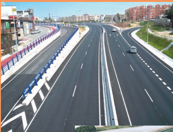
Vista panorámica de la vía parque y del carril bici.
