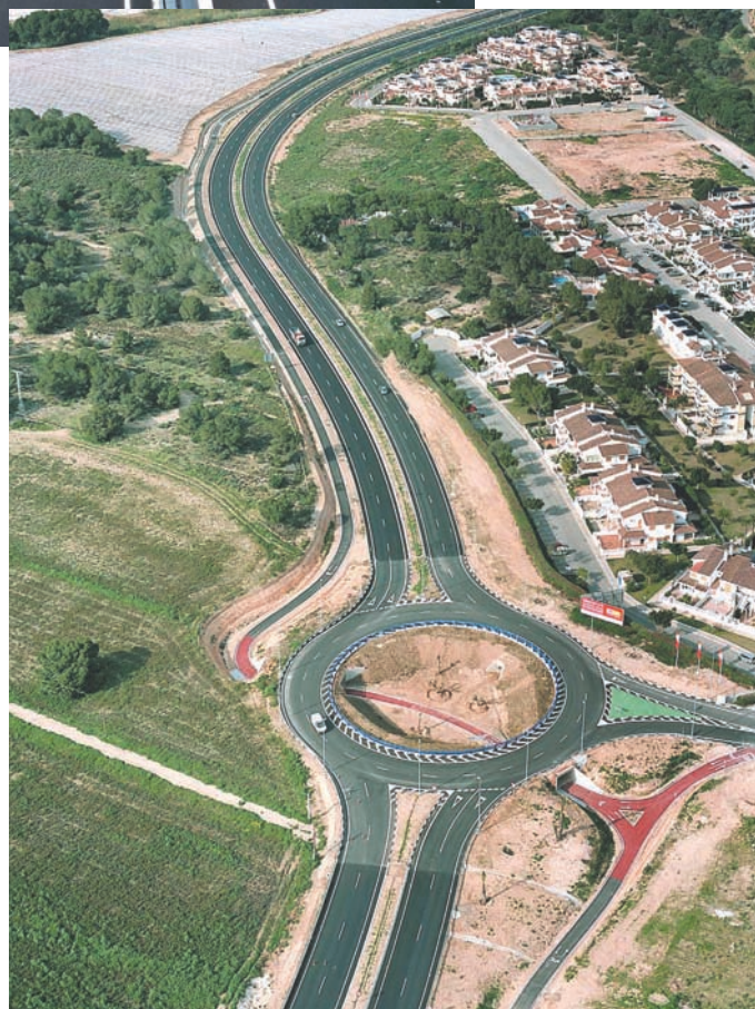
Vista panorámica de la Glorieta Ríomar.
