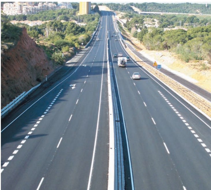
Vista panorámica de la Vía Parque.
