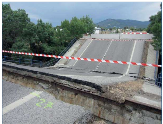
Figura 17. Tablero colapsado hacia a las 14:45 del 29 de mayo de 2015. Vista desde E-1
