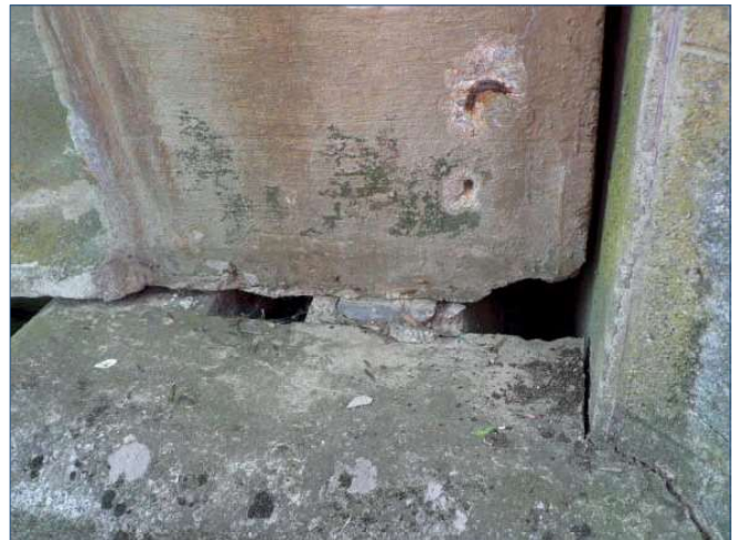
Figura 16. Giro del tablero en lado derecho de E-2. Apoyo sobre péndulo
