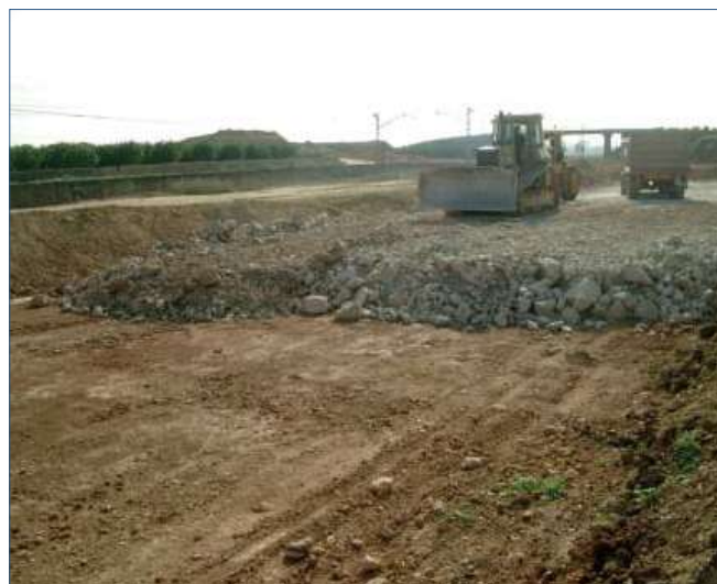
Figura 11. Caso RIB. Relleno de saneamiento con pedraplén (B11). Línea de Alta Velocidad Picassent- Alcásser
