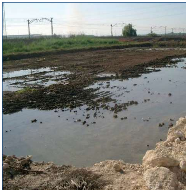
Figura 10. Caso RIB. Saneamiento en terreno de apoyo (B1) en zona con nivel freático alto. Línea de Alta Velocidad Picassent- Alcásser
