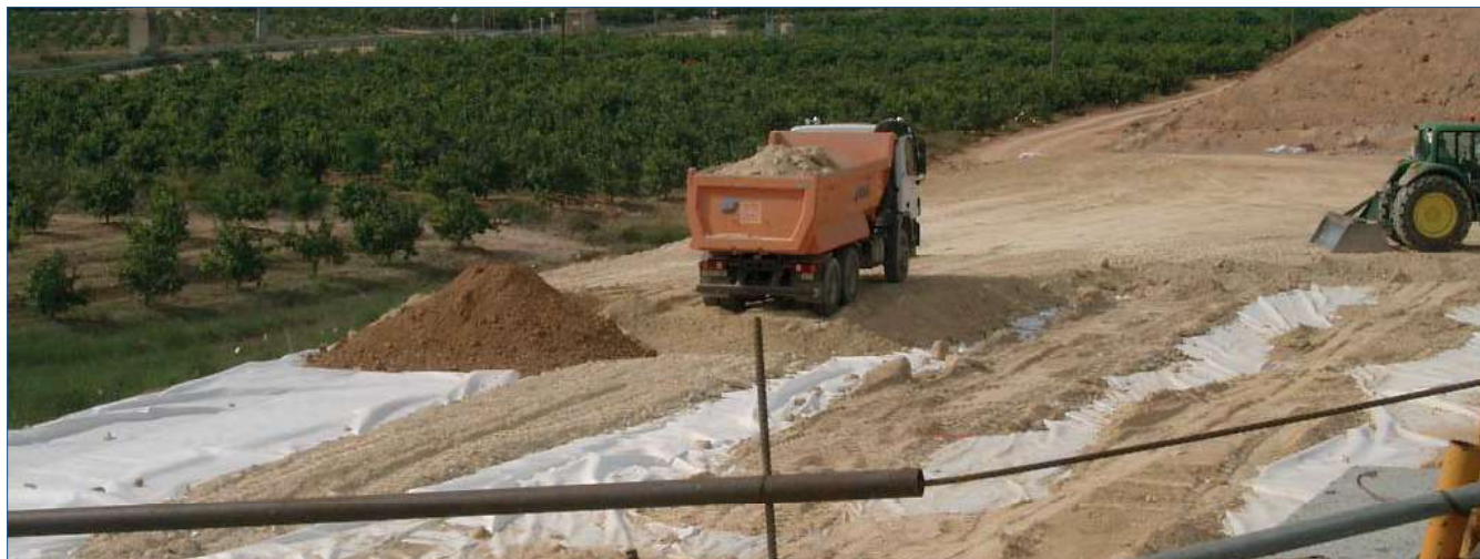
Figura 13. Caso RIB. Geotextil entre el pedraplén del cimiento y el relleno superior (D11). Línea de Alta Velocidad Picassent- Alcásser
