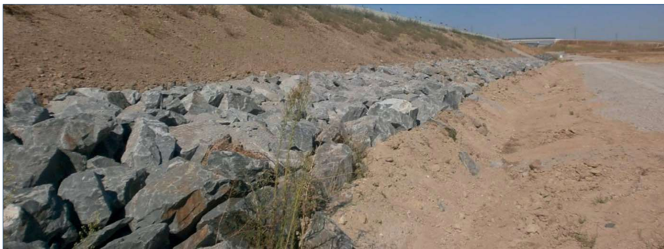
Figura 14. Caso RIB. Protección de escollera (A3). Línea de Alta Velocidad Pozal - Villaverde
