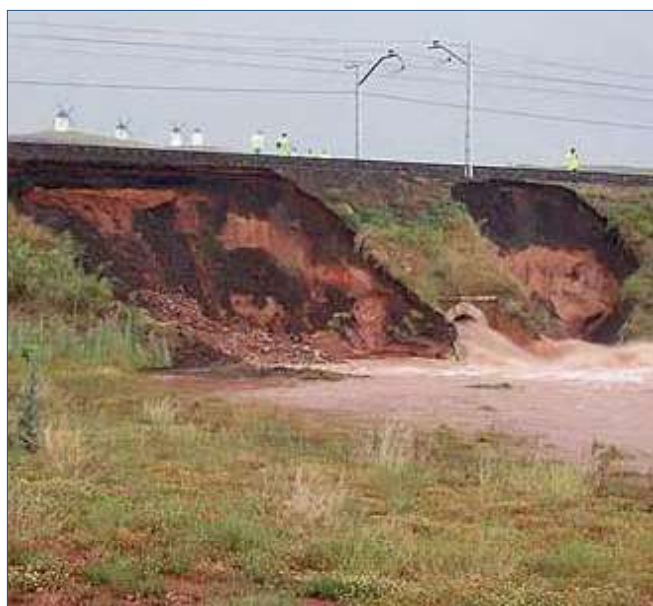
Figura 5. Rotura de un relleno por superación de la capacidad de drenaje transversal. FFCC Alcázar de San Juan – Sevilla, p.k. 150 (Paniagua, I., 2011)
