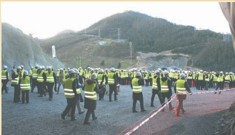
Imágenes de la visita técnica tanto en el exterior como en el interior del túnel y en su unión con los viaductos del enlace del Cadagua.
