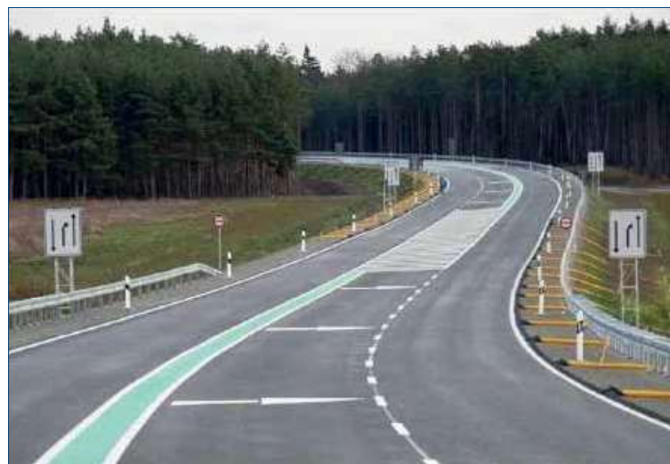
Carretera tipo 2+1. Alemana
