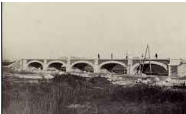
Viaducto de acceso al puente sobre el río Guadalhorce de Pablo de Alzola
