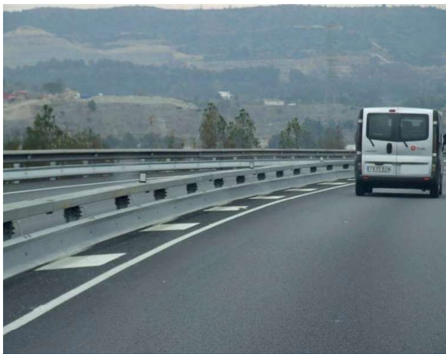
Figura 8. Barrera metálica de baja altura en mediana (Generalitat de Cataluña)
