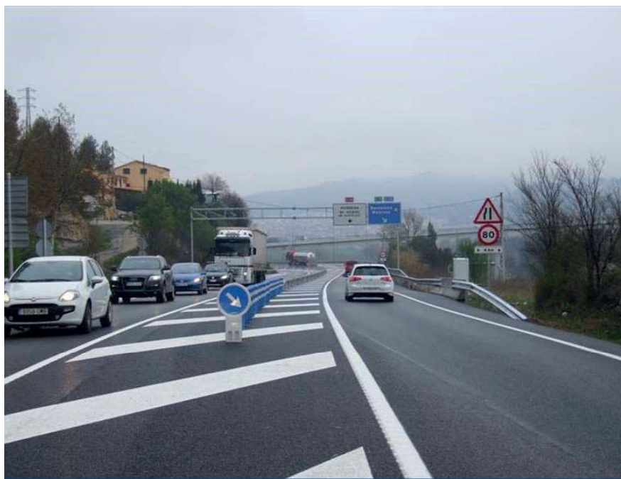
Figura 1. Inicio de carril adicional de adelantamiento (Generalitat de Cataluña)
