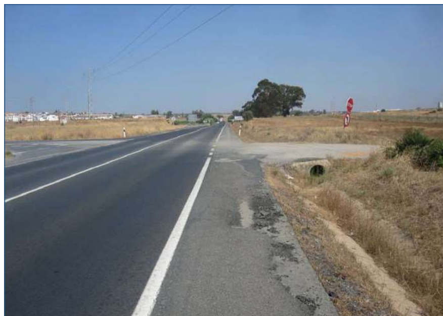
Obstáculos en la margen de la carretera
