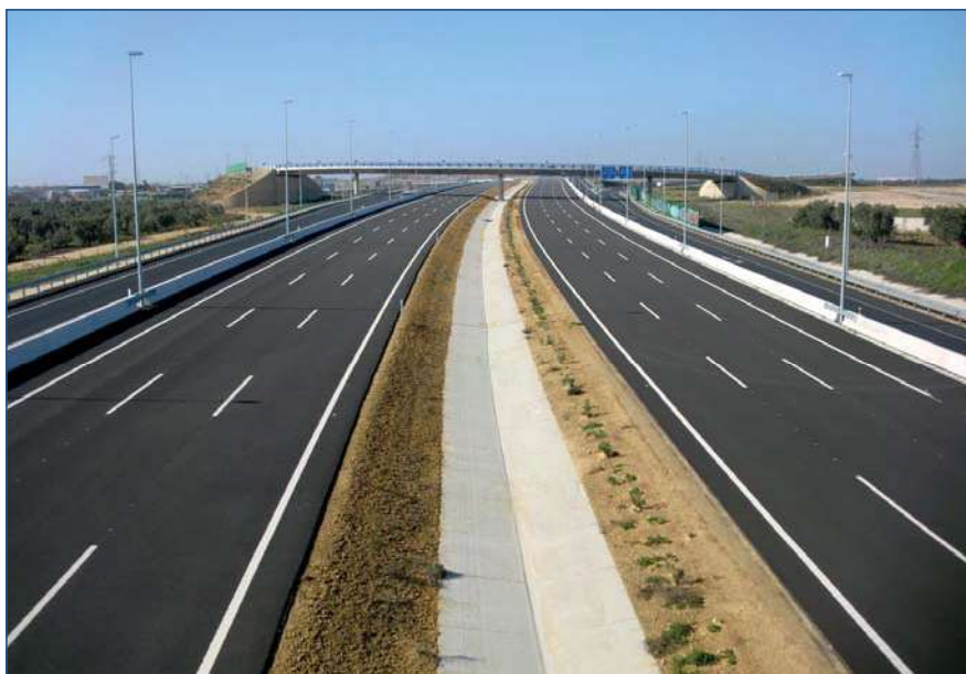
Cuneta de seguridad en mediana
