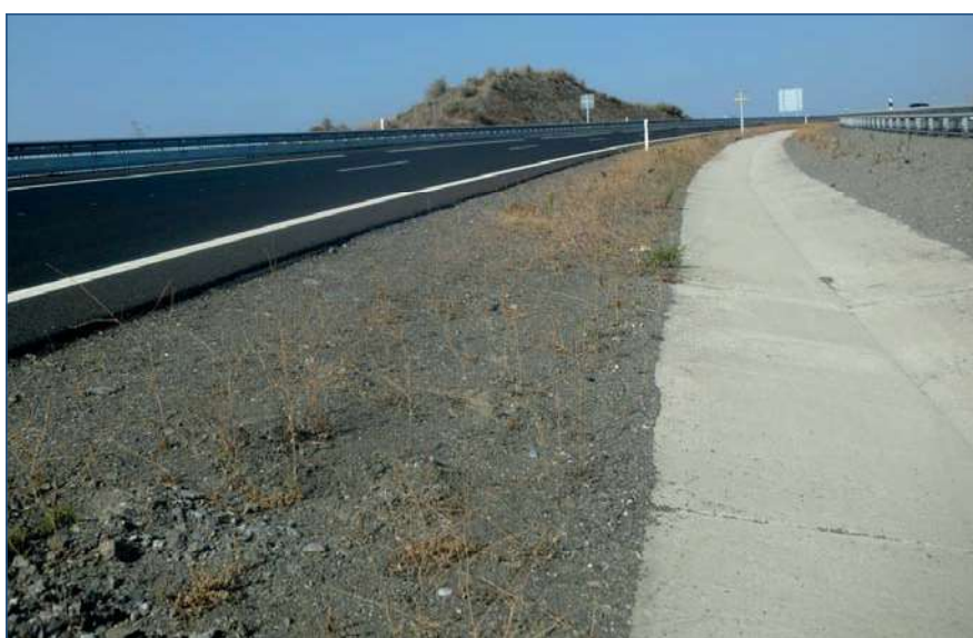
Cuneta de seguridad en mediana
