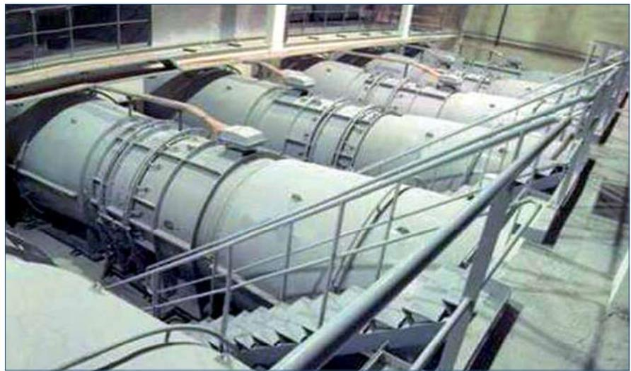
Figura 10. Ventiladores en caverna. Túnel de Somport
