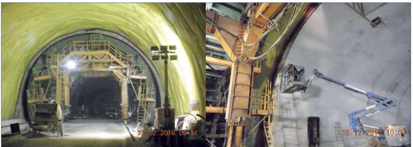
Figuras 13 y 14. Colocación de tubos embebidos hasta la clave en el canto de la junta entre puestas del revestimiento. Túnel de Caldearenas en la A-23
