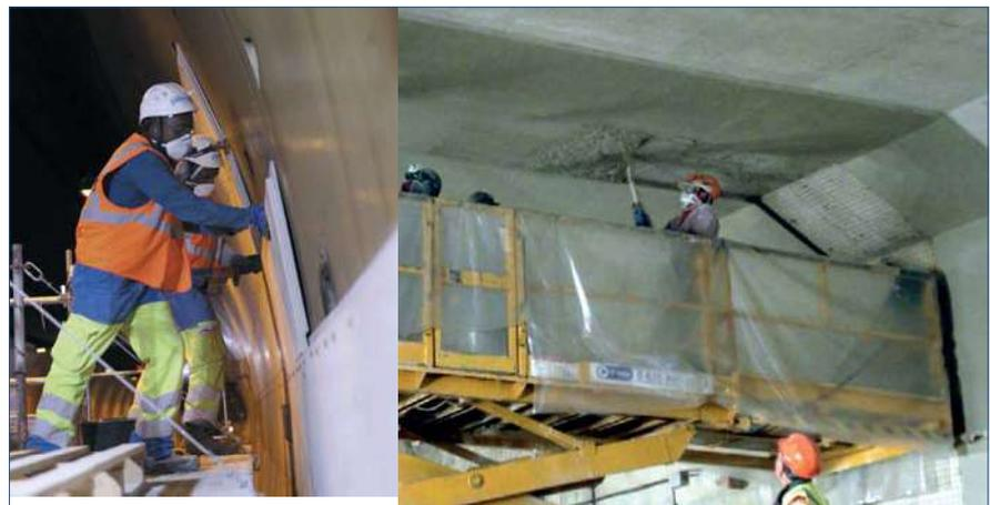
Figura 16 y 17. Protección pasiva contra incendios. A la izquierda colocación de placas y a la derecha material proyectado. Fotografías CETU
