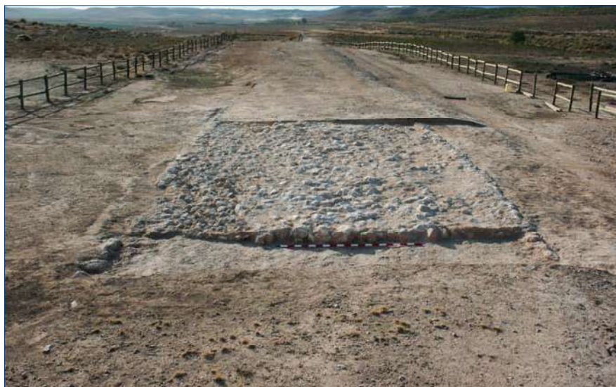
Estructura del afirmado de una vía romana sobre terrenos duros. Vía de Italia a Hispania, en Ablitas (Navarra)
