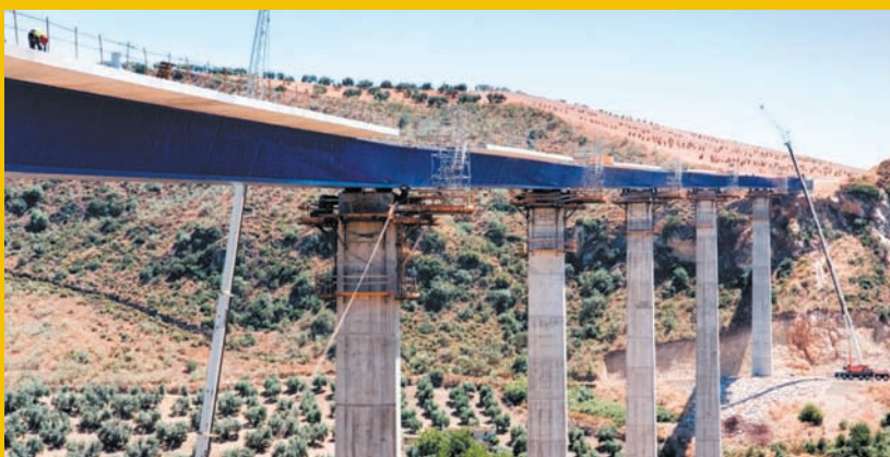
Fases lanzamiento Viaducto E-3
