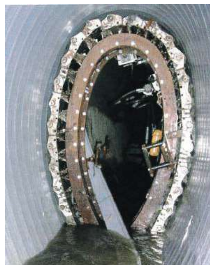
Figura 7. Proceso de enrollamiento espiral
