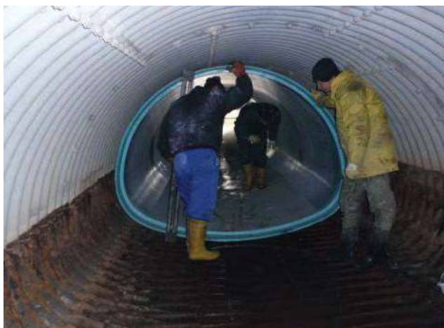
Figura 8. Relining con tubo de PRFV
