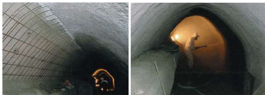
Figura 10. Rehabilitación ODT con hormigón proyectado
