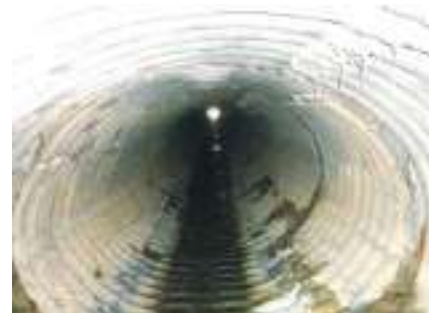
Figura 4. Tubo ovalizado por defecto en rigidez
