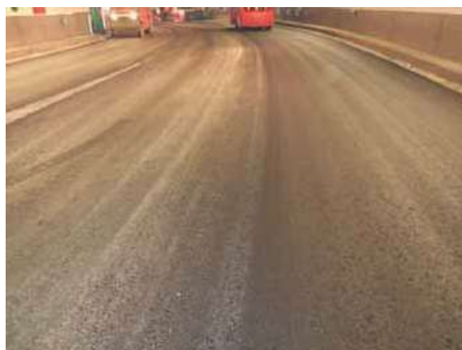
Figura 7. Estado pavimento antes y después de pasar barredora de púas de acero
