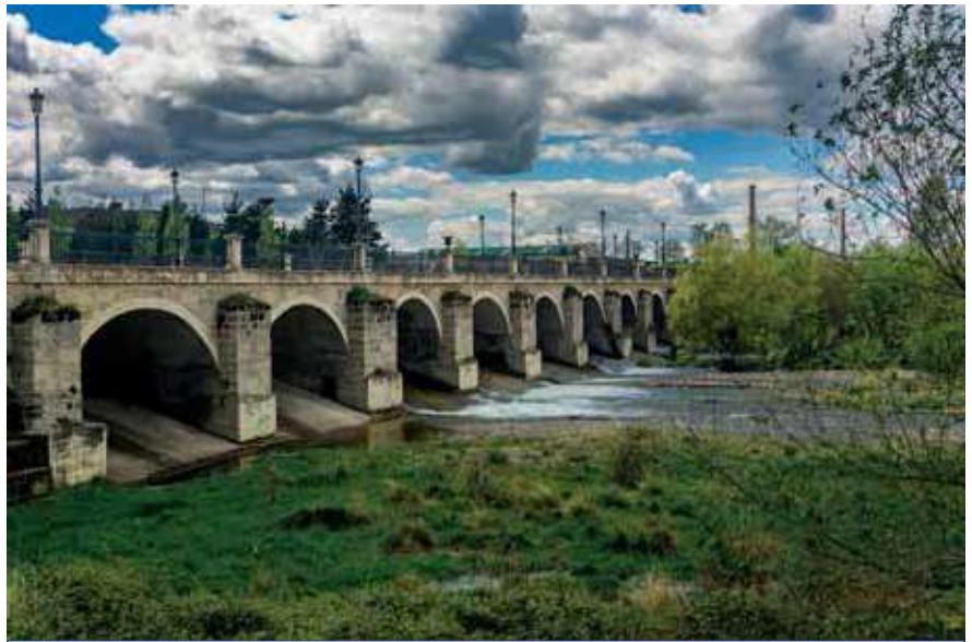
Figura 7. Vista del puente, desde la margen derecha
