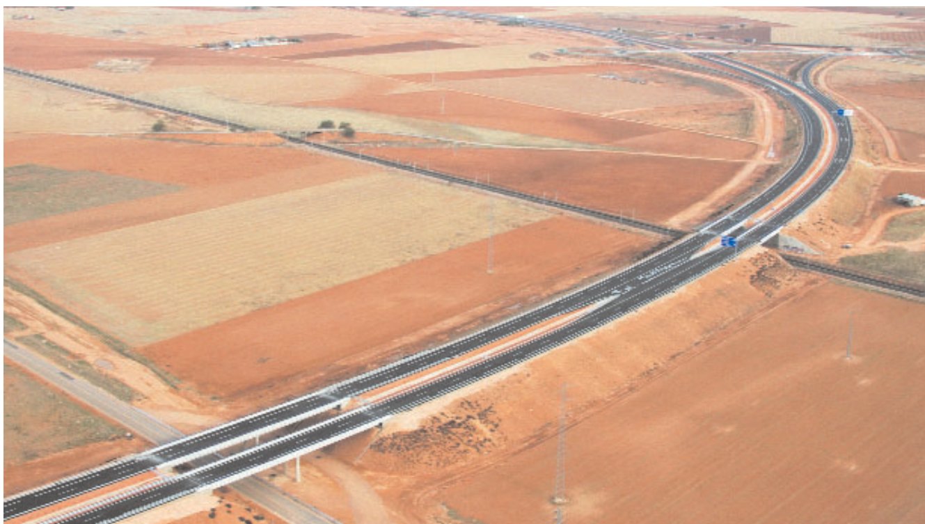
A lo largo del trazado se han diseñado un total de 8 pasos superiores, 3 inferiores y 1 muro. En la foto se aprecia el paso superior sobre la línea de ferrocarril Madrid-Cádiz.
