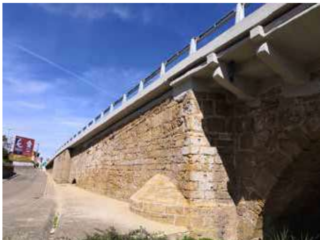
Figura 25. Aspecto parcial de la obra terminada
