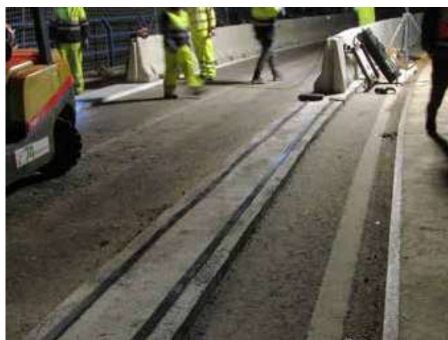
Figura 18. Faja de apoyo ejecutada
