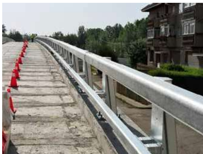
Figura 23. Pretil colocado.
