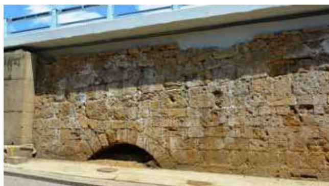
Figura 4. Arquillo primitivo en manguardía sur, lado León
