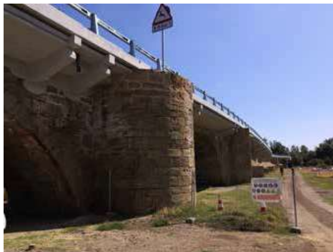
Figura 24. Vista parcial de la obra terminada
