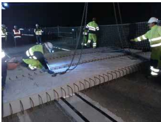
Figura 20. Colocación de prelosa
