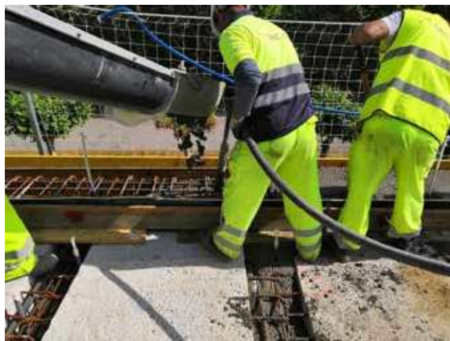
Figura 22. Hormigonado de juntas y pedestal de pretil
