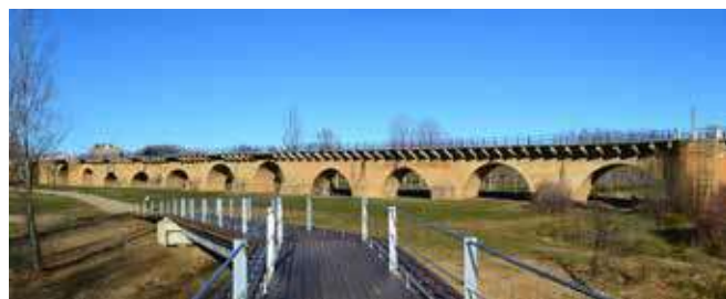
Figura 2. Situación del puente previa a la actuación
