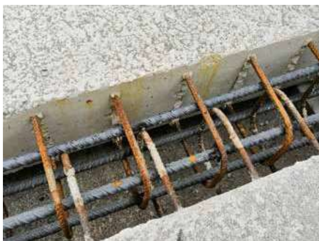
Figura 21. Juntas entre losas antes del hormigonado
