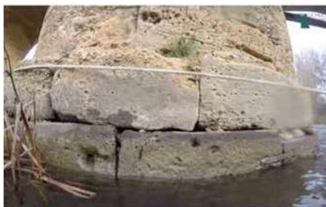
Figura 9. Juntas lavadas sobre la lámina de agua
