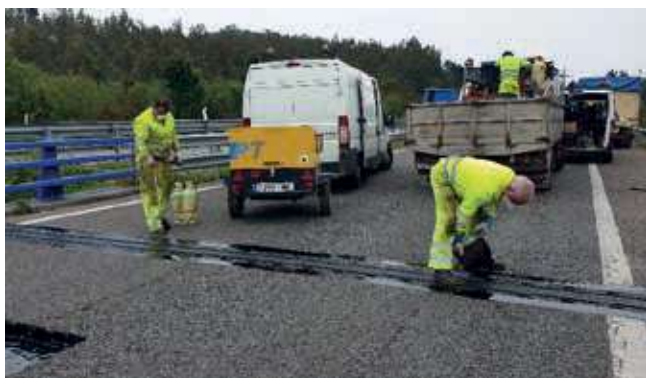
Trabajos de conservación con medidas de seguridad y distanciamiento
