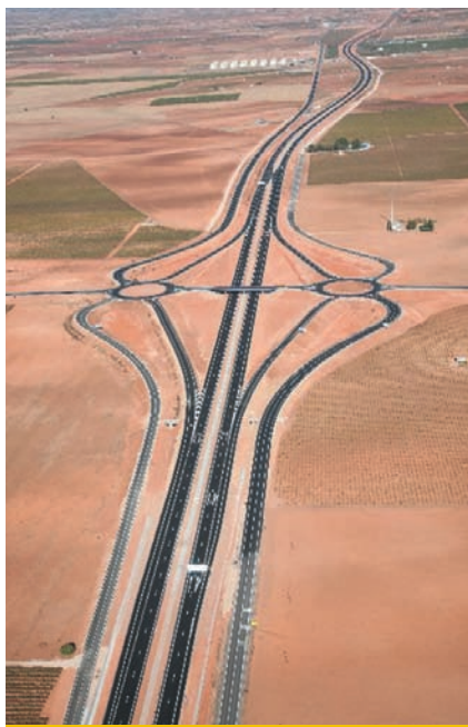
Vista panorámica del enlace con la CM-3111.
