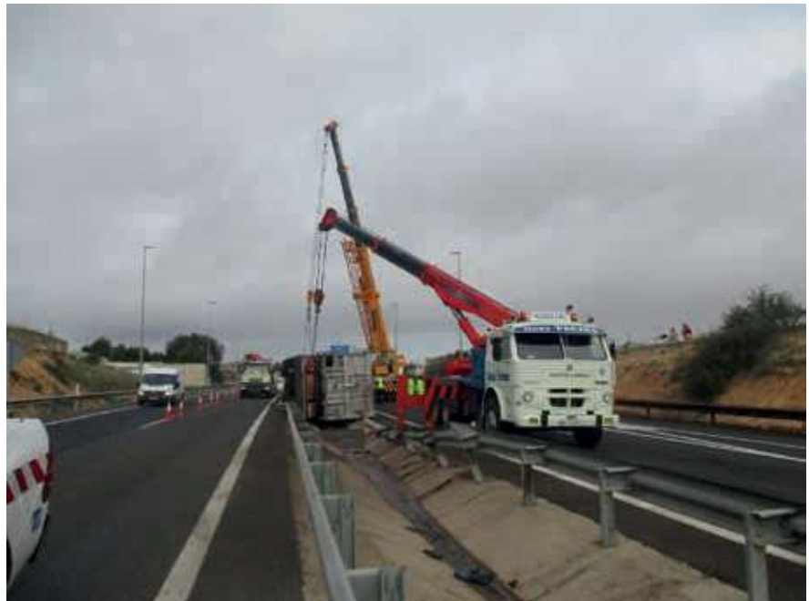
Figura 7. Las operaciones de conservación y en especial las de atención a accidentes e incidentes han seguido siendo esenciales durante el estado de alarma
