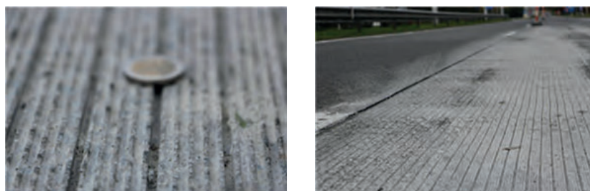
Figura 0. Aspecto de una sección de una realización en Bélgica [2]
