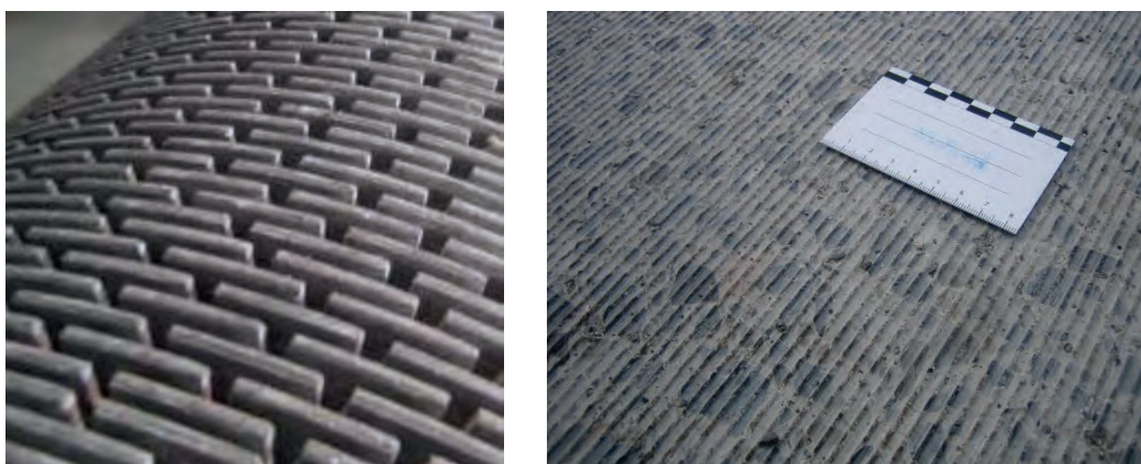
Figura 2. izquierda: tambor de microfresado y derecha: textura típica de microfresado con discos de diamante [1]
