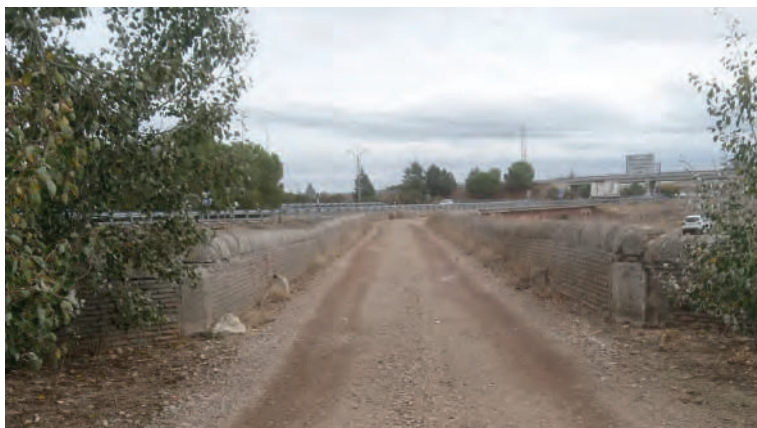
Figura 16. Puente del P. Pontones sobre el río Zapardiel, en S. Vicente, cerca de Go-meznarro (Valladolid). Se aprecian el pavimento (zahorra compactada) y los guarda-ruedas. Foto de los autores
