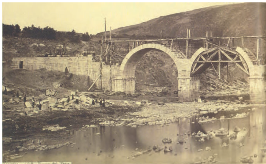
Figura 14. Empleo de cimbras para la construcción de un puente sobre el río Tera (Zamora) (Foto Laurent, mediados del s. XIX)
