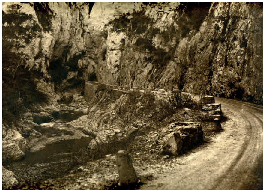
Guardarruedas y pretilles alternados. Carretera de Lapeña a Ansó. Foz de Biniés. Fotografía de 1929. Unidad de Carreteras de Huesca, MITMA.
