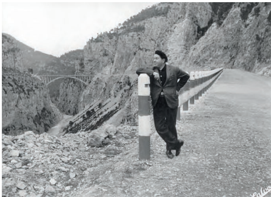
D. Gil Garrido Oliver, constructor del puente de Santa Cruz de Moya, en un tramo de los accesos al puente protegido con valla metálica acorde con las Instrucción de Carreteras de 1939. El puente se inauguró en 1963.
