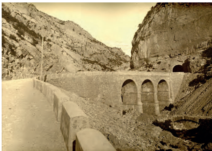
Pretilles discontinuos en los accesos y continuos en el puente. Carretera de Huesca a la estación de ferrocarril de Sabiñánigo. Puente sobre el río Isuela. Año 1929. Unidad de Carreteras de Huesca, MITMA.
