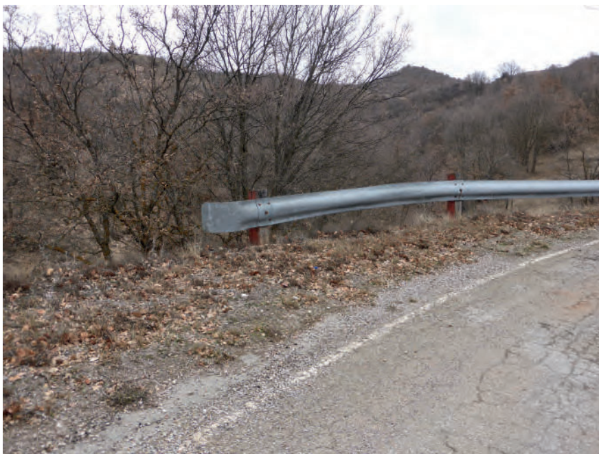
Barrera metálica de una sola onda y postes de madera. Antigua carretera N-211; puerto de Bañón (Teruel).
