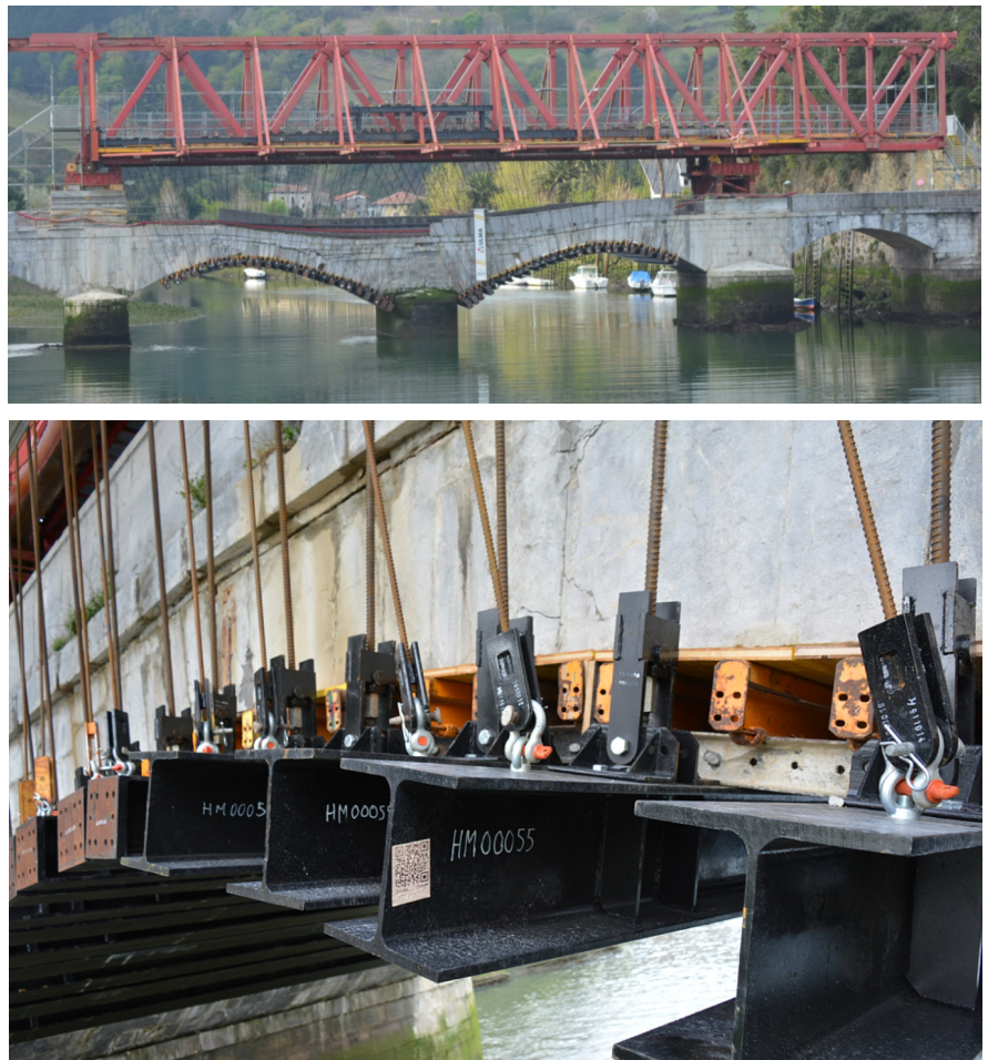
Figura 11. Apeo de las bóvedas del puente de Deba y aprestes dispuestos para su sujeción. Desarrollo de ULMA a partir de la propuesta de FHECOR-INJELAN. Fotos de los autores
