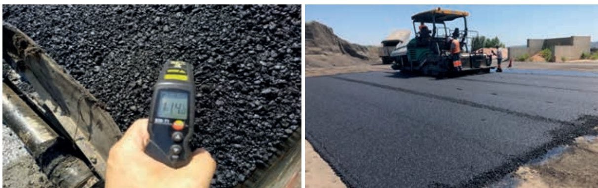
Fotografías 9 y 10. Mezcla bituminosa en la tolva de la extendedora (izquierda) y extendido en tres franjas (derecha).
