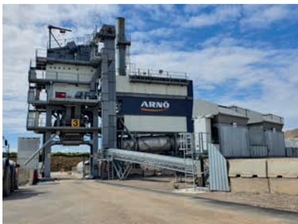
Fotografías 1 y 2. Tolvas para la introducción de áridos y RAP fríos (izquierda) y sistema de evacuación de vapor (derecha)
