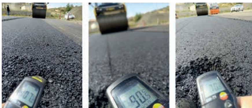
Fotografías 11 y 12. Temperaturas de inicio de compactación.
