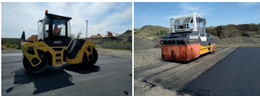
Fotografías 13 y 14. Compactador tándem (izquierda) y de neumáticos (derecha).
