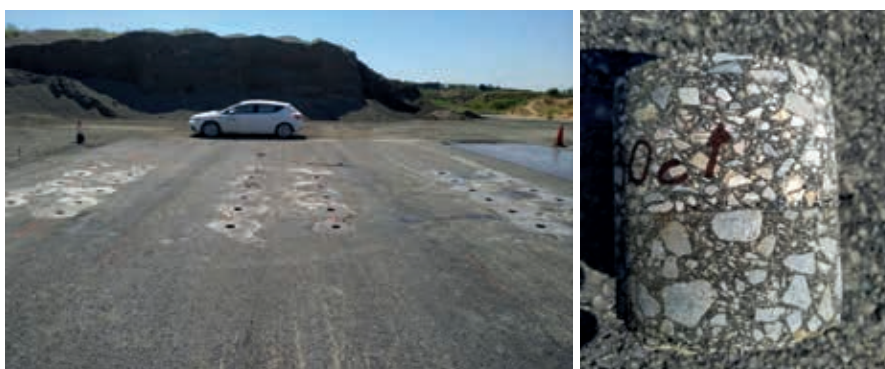
Fotografías 15 y 16. Tramo experimental después de la extracción de testigos (izquierda) y aspecto de uno de los testigos extraídos (derecha).
