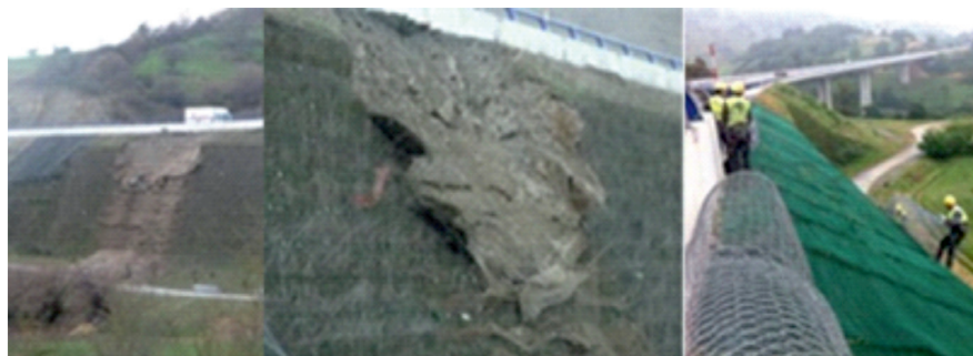
Figura 13. Muro verde con bulones autopercutorantes en la autovía A-67.
