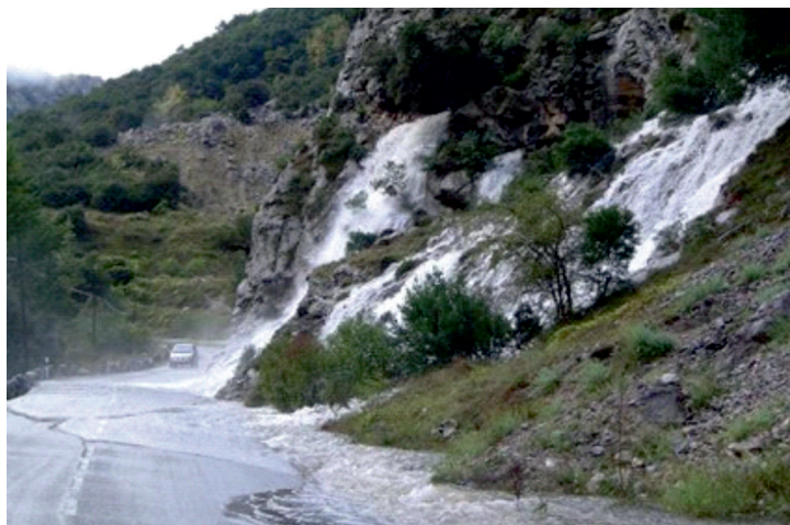
Figura 1. Situación del PK 158,140 MI producido por las fuertes lluvias en la ladera rocosa (aguas arriba) sin actuar.
