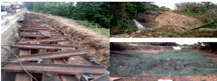
Figura 14. Hinca de carriles, colocación de geomalla, red de cables atornillados y reconstrucción de la canaleta de agua en la carretera N-623 a causa de las fuertes lluvias
