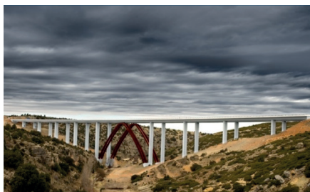
Viaducto de Albentosa. Autovía A-23. Teruel
