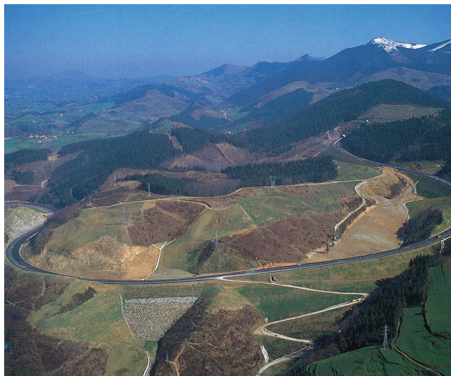
Autovía de Leizarán (Guipúzcoa - Navarra)
