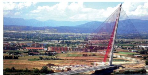
Puente atirantado. Talavera de la Reina
