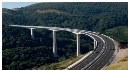
Viaducto de Montanliz. Autovía A-67. Cantabria
