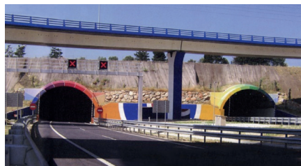
Túnel M-111. Madrid Aeropuerto
