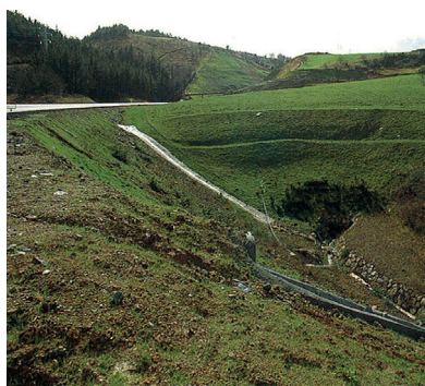
Autovía de Leizarán. Guipúzcoa - Navarra
