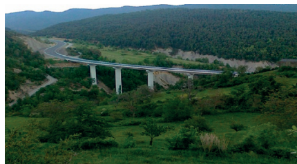
Viaducto de Fanillo. N-260. Sabiñanigo-Fiscal
