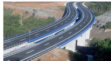
Viaducto de Tiermas. Autovía A-21. L.P. Zaragoza/Navarra
