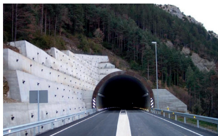
Túnel de Campo. Huesca
