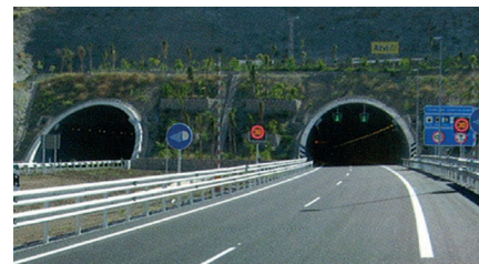
Túnel de Cantalobos. Granada
