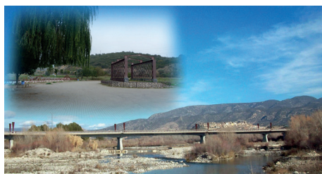
Área de descanso Junto al puente Las Pilas. N-123 (Huesca)
