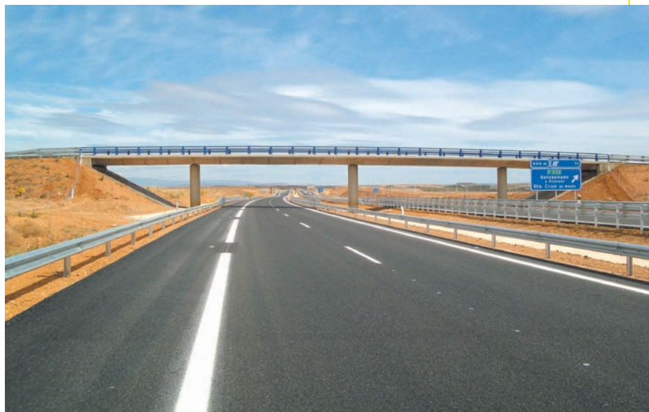
Vista del tramo finalizado en el p.k. 2+400.
