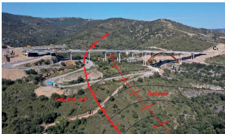
Figura 10. Panorámica de plegamiento rollover en el Barranco de la Bota asociado al labio hundido de la Falla P.K. 1,91 (Mayo 2022)
