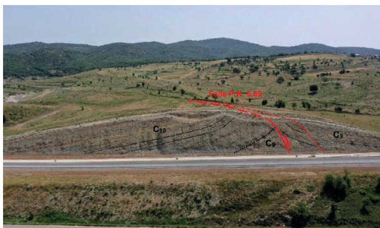
Figura 20. Panorámica de la Falla P.K. 6,59 con pliegue de arrastre y anticlinal debido a una posible reactivación tectónica durante el Cenozoico (Junio 2022)
