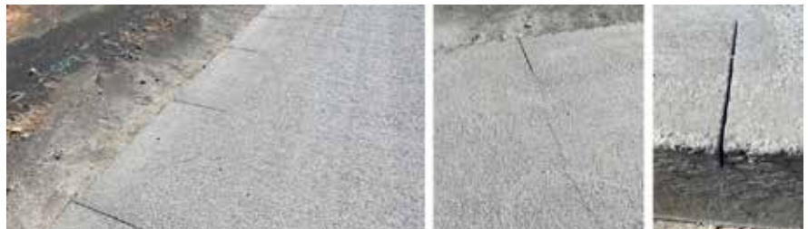
Figura 26. Cortes para inducción del patrón de fisuración
