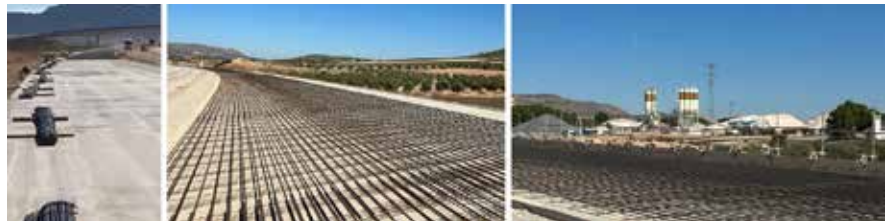
Figura 16. Armado del pavimento
