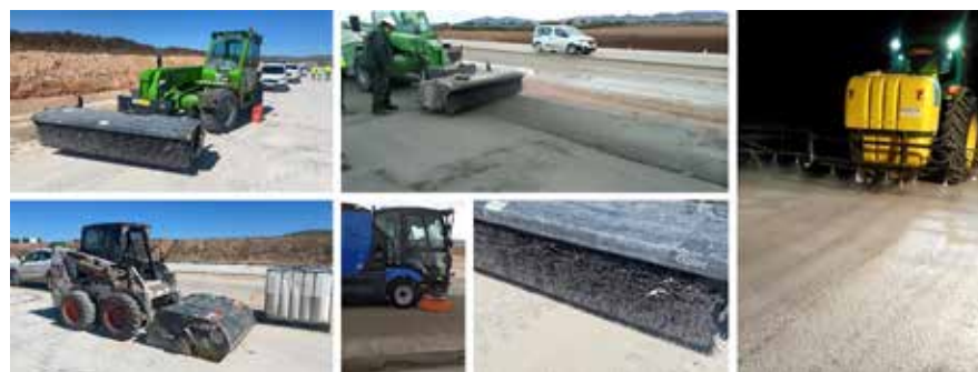
Figura 23. Operaciones de barrido, limpieza y curado final
