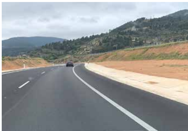
Figura 4. Apartadero exterior sobre cuneta de seguridad
