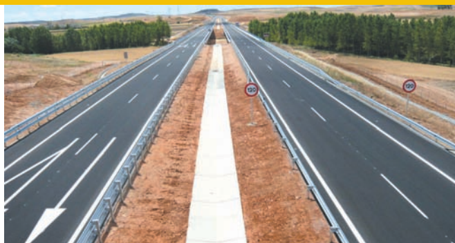
Vista del tramo en el p.k. 1+000.
