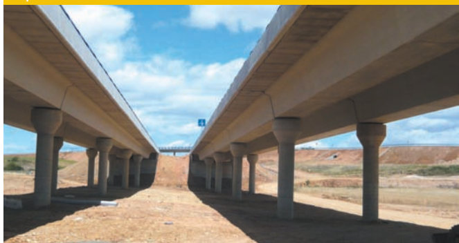
Viaducto sobre el río Burejo.
