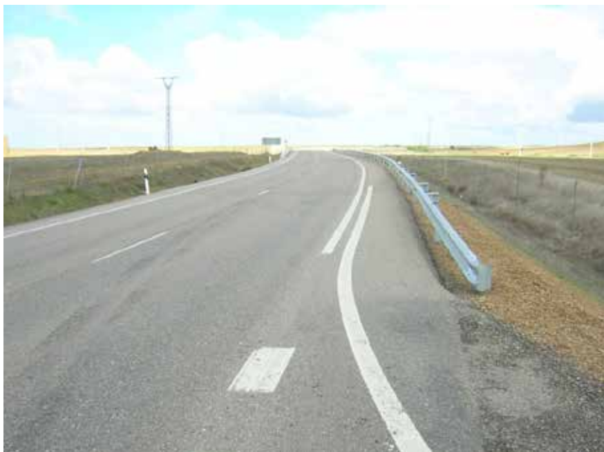
Foto 4. Abatimiento con pieza tope sin enterrar
