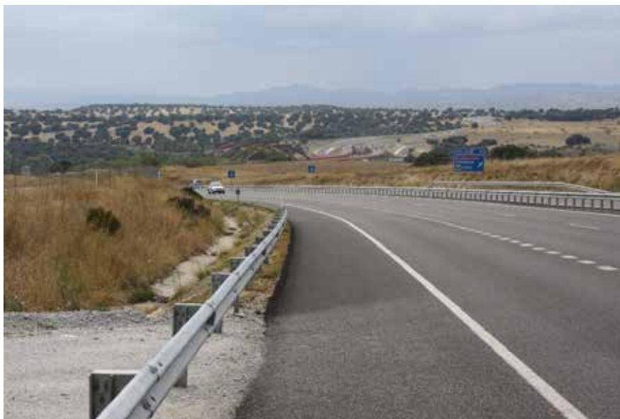
Foto 1. Barrera de seguridad
