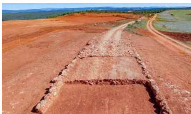
Sección del firme de la calzada romana en su tramo entre Augustobriga, Numancia y Uxama. Isaac Moreno Gallo.
