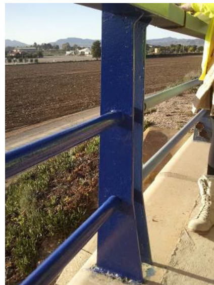
Figura 3. Aplicación de una capa de acabado con ligante base silicona de alta resistencia a intemperie, de espesor mínimo de 50 micras por capa, de color RAL 5002 (azul nuclear)
