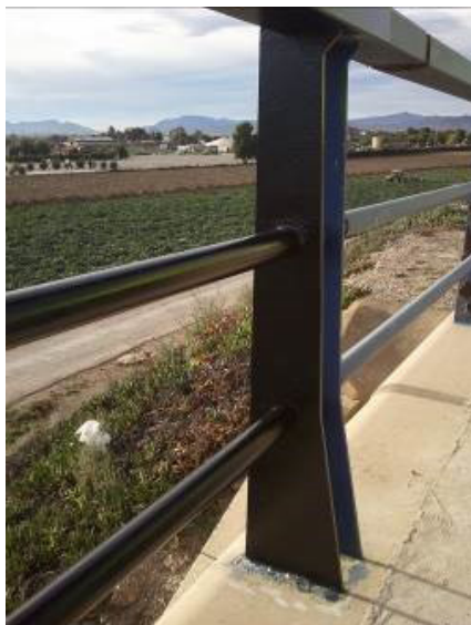
Figura 2. Aplicación de una capa intermedia de ligante epoxídico rico en oligisto micáceo altamente laminar con un espesor mínimo de 150 \mu\text{m} , en color RAL 9005 (Negro).
