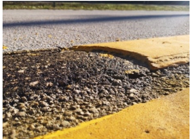
Figura 6. Marca vial eliminada mediante sistema mixto con raspado e hidrobarrido (HOG TUSK). (ITOC 12772 a 12778_Borrado de marcas viales)
