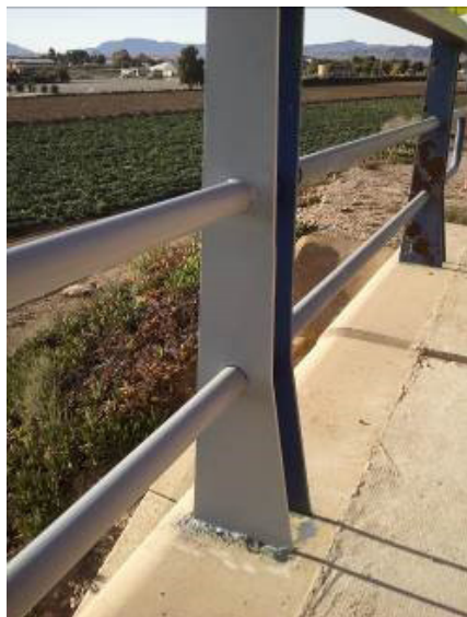
Figura 1. Aplicación de una capa general con una pintura antioxidante epoxi de dos componentes, con posibilidad de base agua, de al menos 600 horas de resistencia en ensayo de niebla salina según UNE-EN ISO 11997-1, en color RAL 7036 (Gris). Espesor nominal de película seca \geq 50 \mu\text{m}
